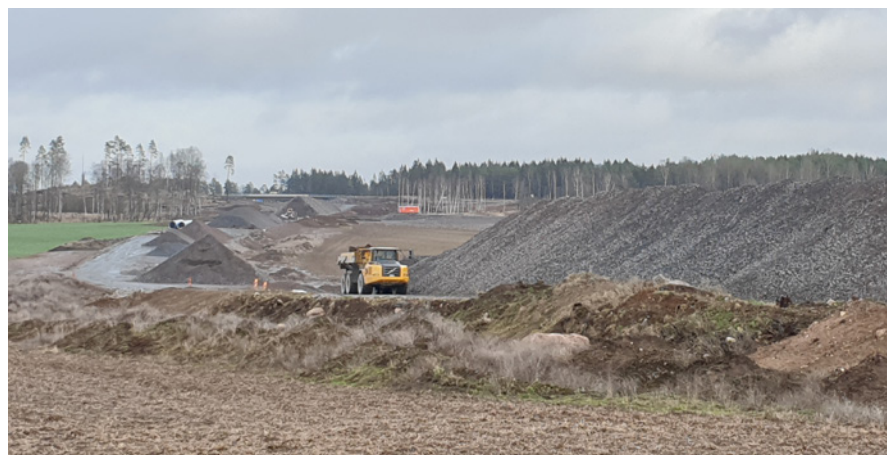
Figur 49. Exempelbild som illustrerar mellanupplag av krossmassor som har lagts upp utmed pågående arbete för väg E20 vid Vårgårda.
