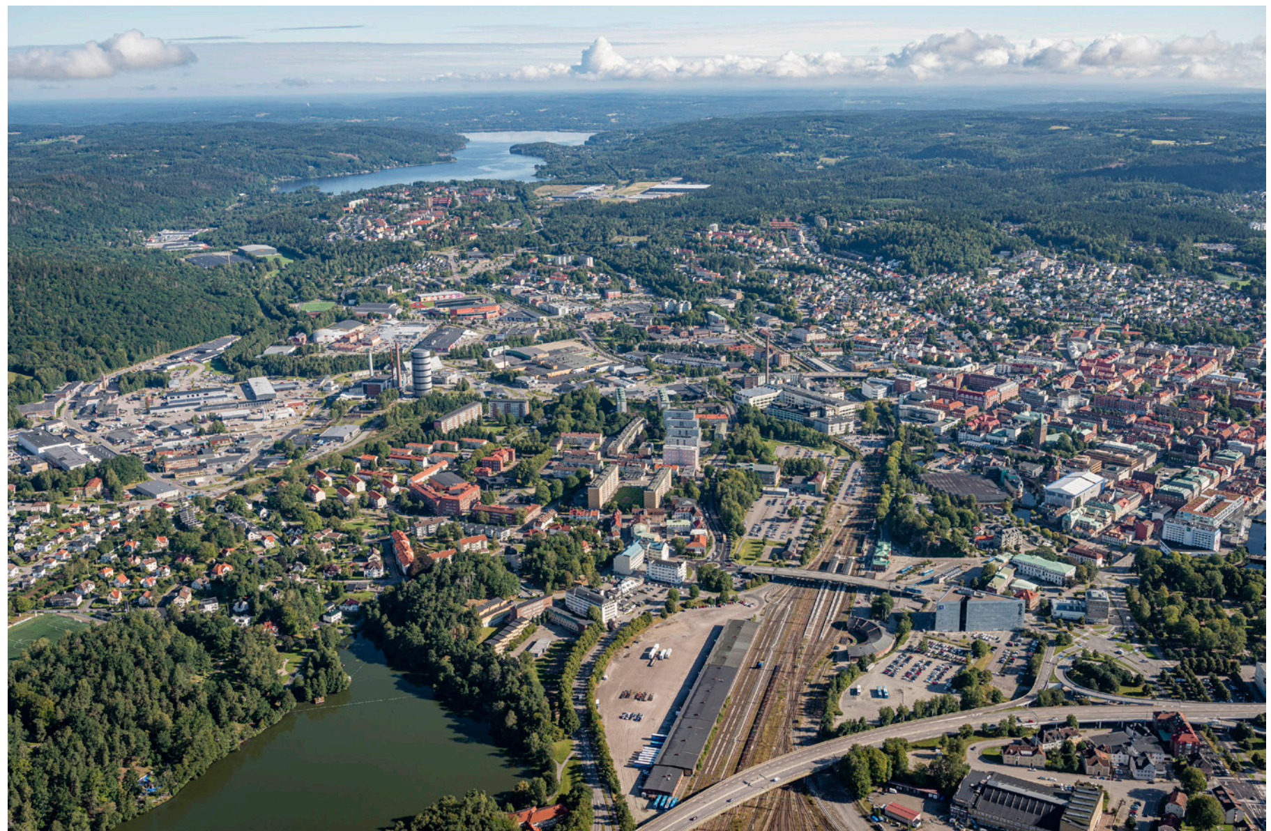
Figur 11. Flygfoto över Borås, vy mot nordost. På bilden syns Ramnasjön och Borås Resecentrum närmst i bild. Uppåt i bild syns Öresjö och till höger i bild syns stadskärnan. (Foto: Per Pixel, 2020)
