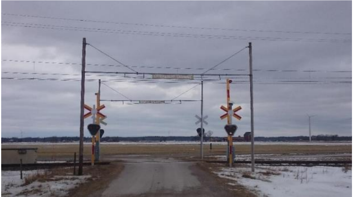
Figur 5.1-2. Ungefärlig utformning av elskyddsportal.
