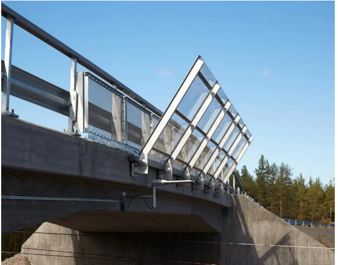
Figur 5.1-3. Exempel på elskyddsskärm.
