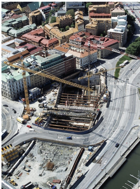
Figur 14. Trafiken leds över på färdigbyggd tunneldel. Exempel från Götatunneln.
