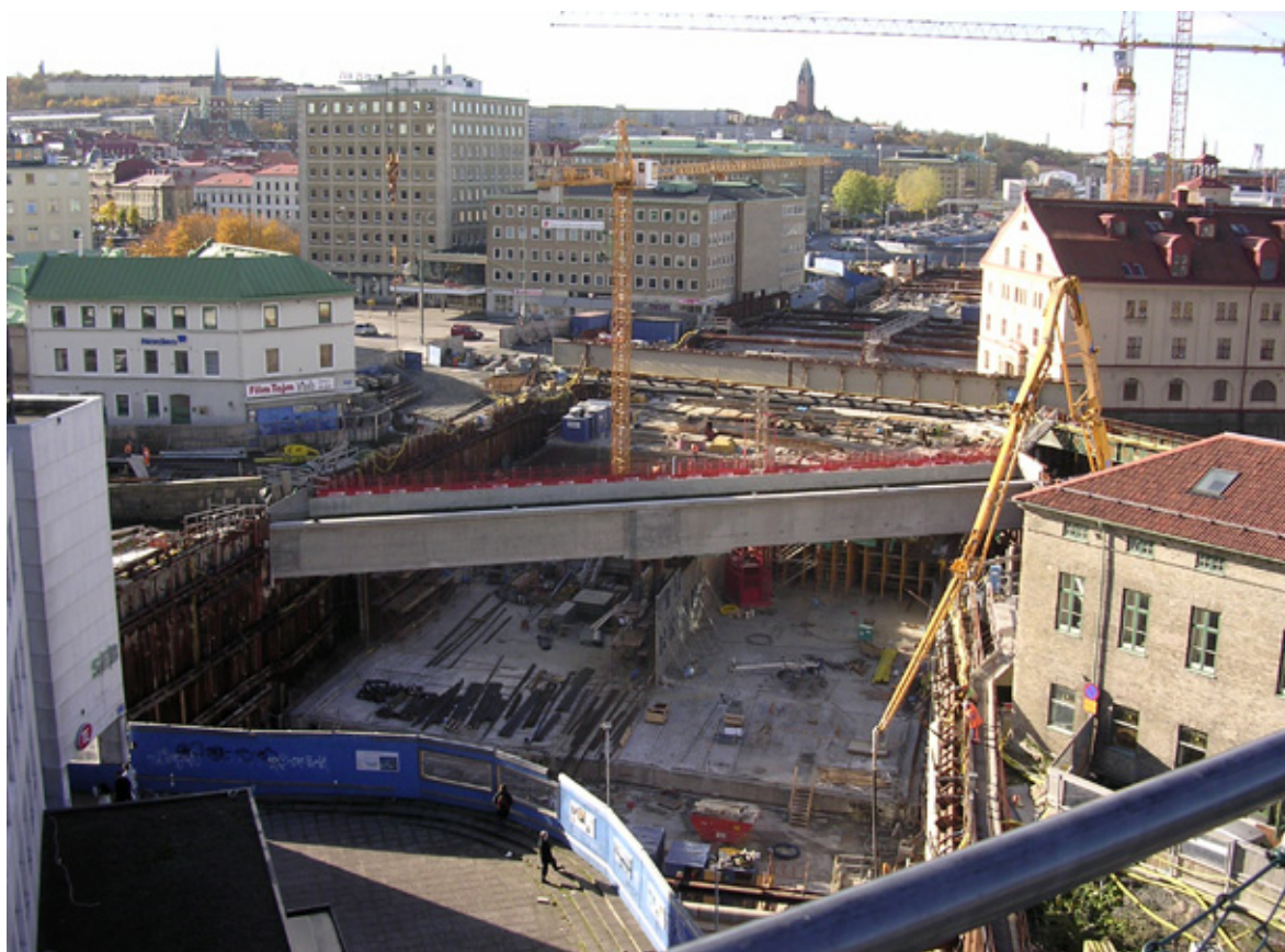
Figur 26. Bild som visar arbetet med Götatunneln. Rosenlundska-nalen leddes i en akvedukt över byggschaktet, medan gångtrafiken leddes runt.
