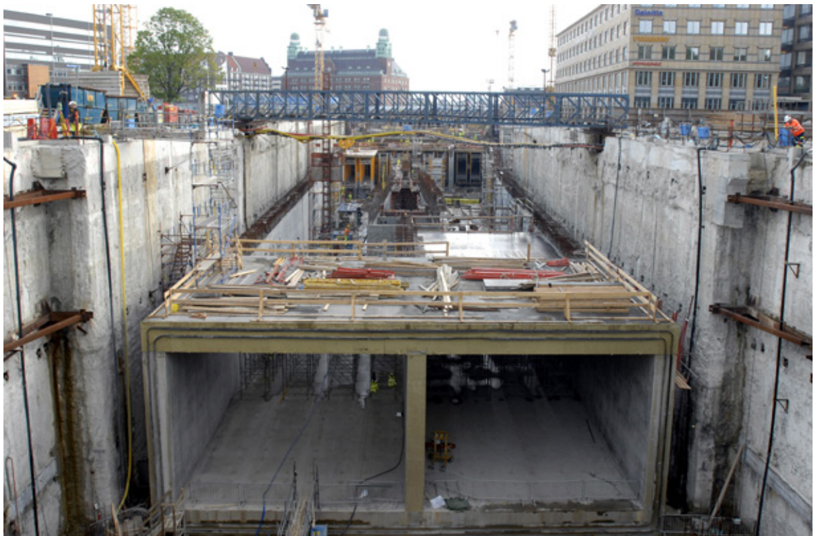
Figur 31. Exempel på djupt schakt under byggtiden (Citytunneln i Malmö 2007).
