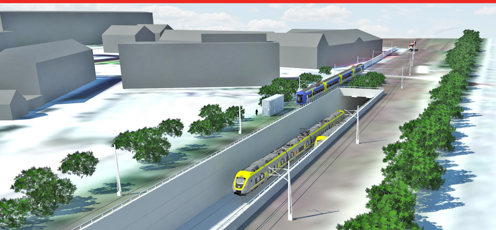
Anslutningen i Almedal sedd söderifrån. Västlänkens tunnel ansluter i ett tråg mellan befintliga spår som flyttats isär.
