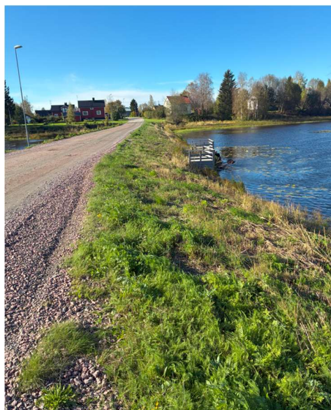
Figur 6. Vägslänten på vägens norra sida. Fotot är taget i västlig riktning.
