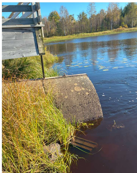
Figur 12. Västra trumma, utloppet (trummans södra ände)
