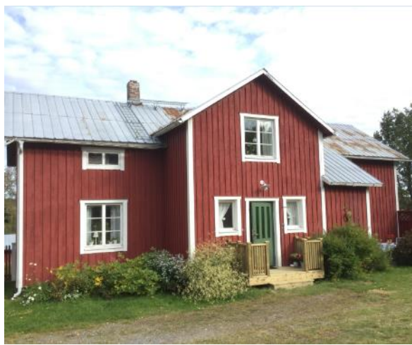
Fasad 2 baksida, sett från vägen
