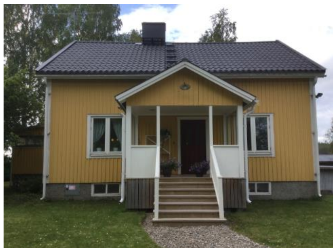
Fasad 1 fasad mot väg 363
