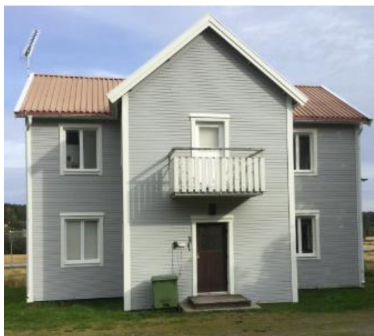
Fasad 2 baksida, sett från vägen
