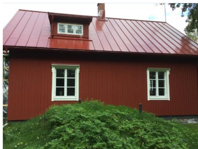
Fasad 4 vänster fasad, sett från vägen. (S)
