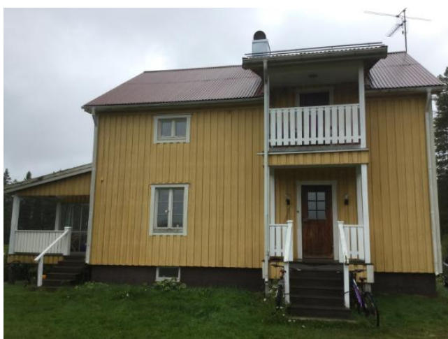
Fasad 2 baksida, sett från vägen
