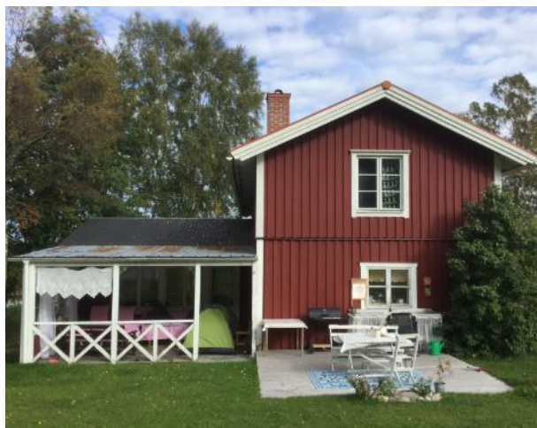
Fasad 2 baksida, sett från vägen
