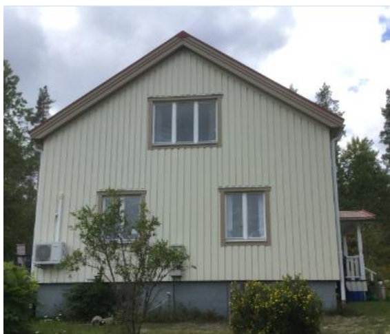
Fasad 1 fasad mot väg 363
