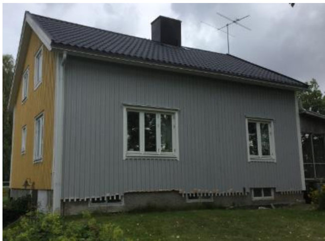
Fasad 2 baksida, sett från vägen
