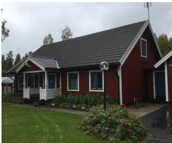
Fasad 2 baksida, sett från vägen
