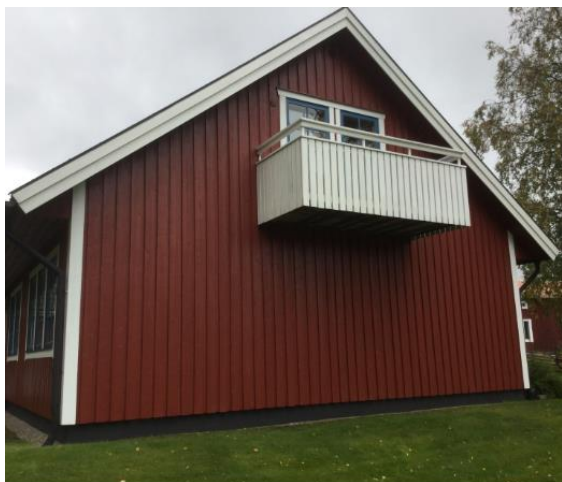
Fasad 3 höger fasad, sett från vägen.
