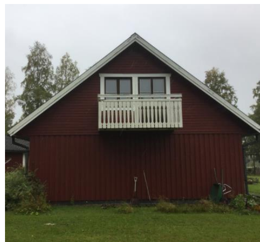
Fasad 4 vänster fasad, sett från vägen.
