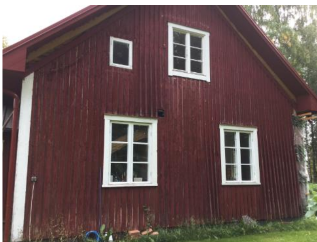
Fasad 2 baksida, sett från vägen (V)
