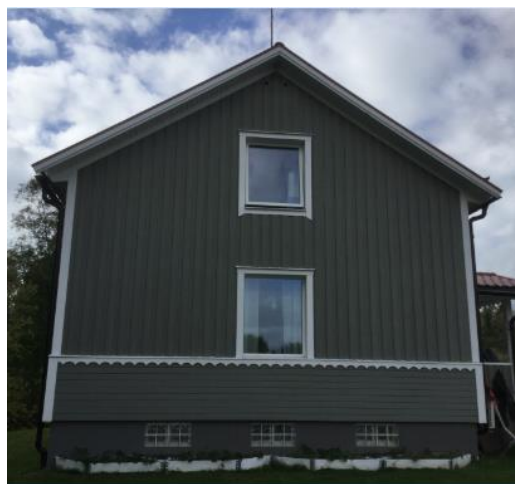
Fasad 2 baksida, sett från vägen
