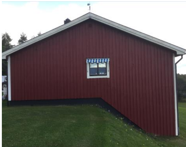
Fasad 4 vänster fasad, sett från vägen.
