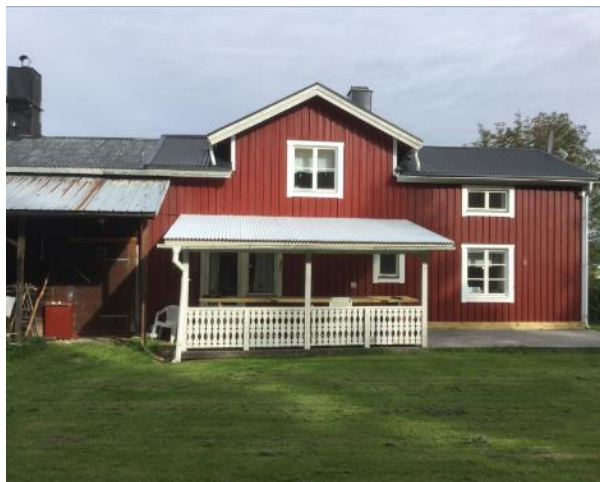
Fasad 2 baksida, sett från vägen
