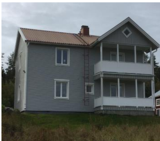
Fasad 1 fasad mot väg 363
