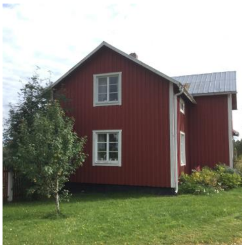
Fasad 3 höger fasad, sett från vägen.
