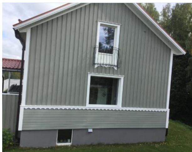
Fasad 1 fasad mot väg 363
