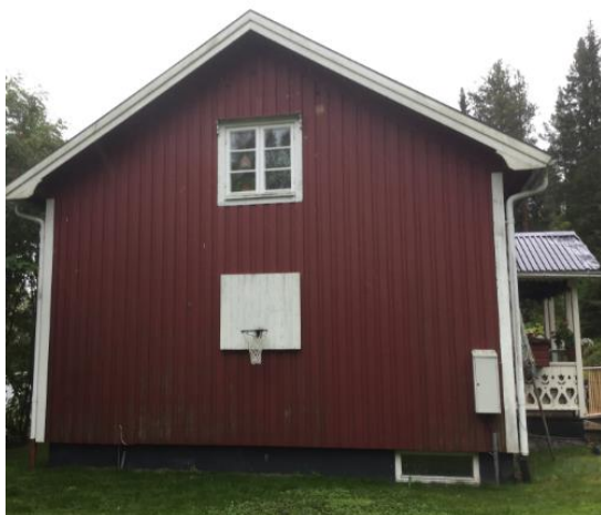
Fasad 3 höger fasad, sett från vägen.
