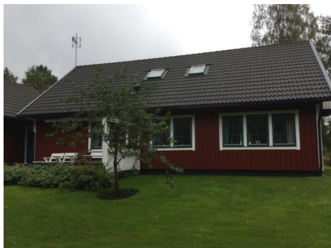
Fasad 1 fasad mot väg 363
