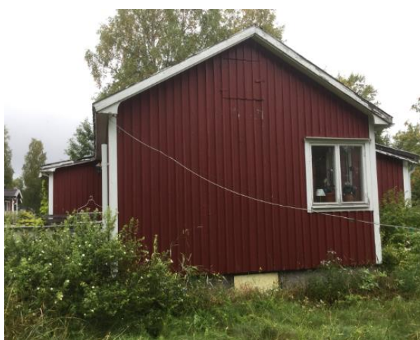
Fasad 4 vänster fasad, sett från vägen.
