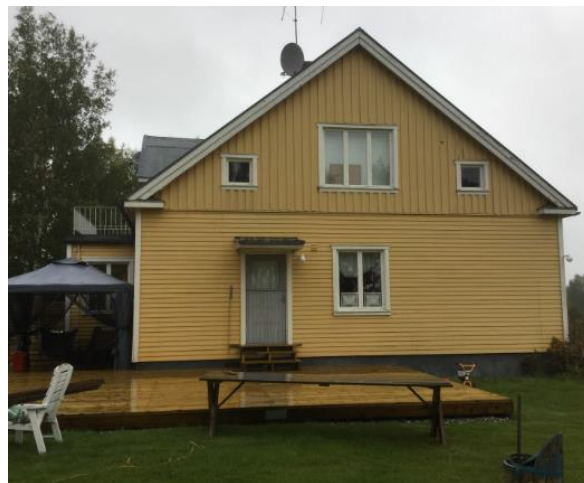
Fasad 4 vänster fasad, sett från vägen.
