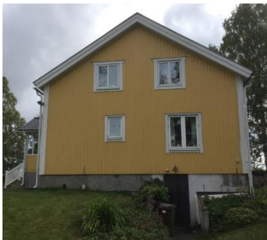
Fasad 3 höger fasad, sett från vägen.
