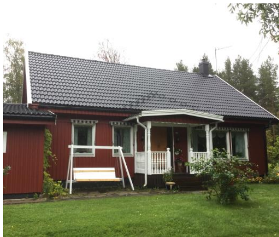
Fasad 1 fasad mot väg 363
