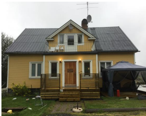
Fasad 2 baksida, sett från vägen
