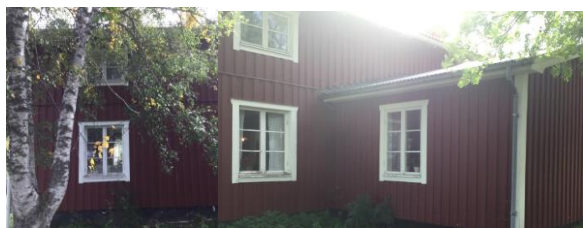
Fasad 3 höger fasad, sett från vägen.
