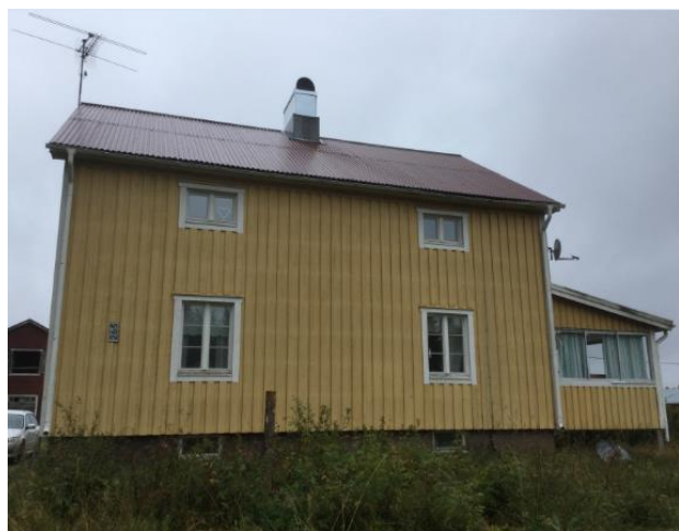
Fasad 1 fasad mot väg 363
