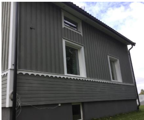
Fasad 3 höger fasad, sett från vägen.
