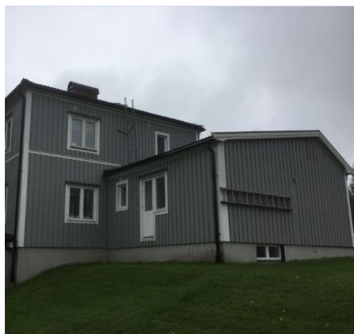
Fasad 3 höger fasad, sett från vägen.
