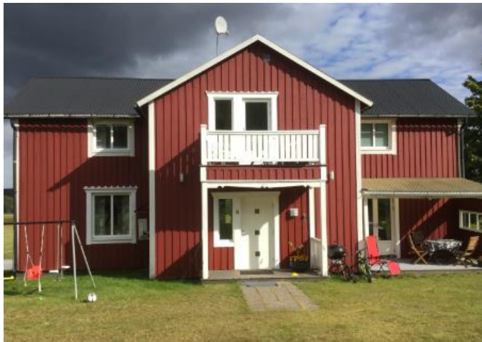
Fasad 2 baksida, sett från vägen
