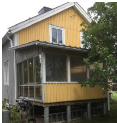
Fasad 4 vänster fasad, sett från vägen.
