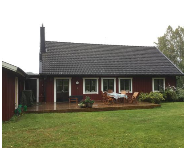
Fasad 2 baksida, sett från vägen
