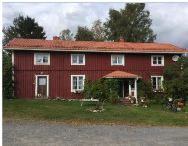
Fasad 4 vänster fasad, sett från vägen.
