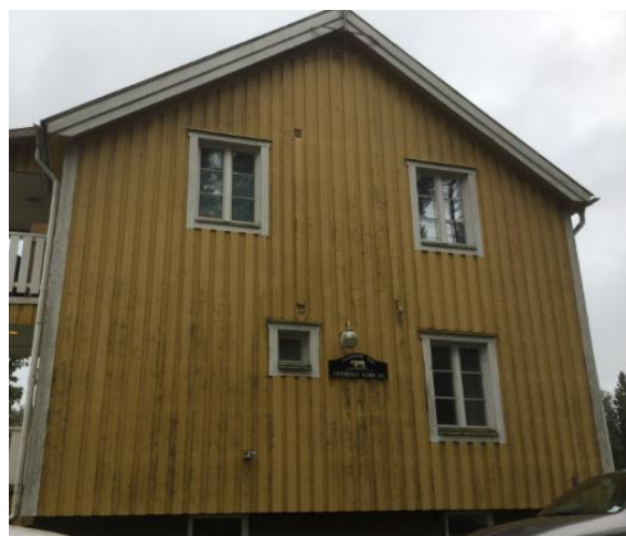
Fasad 4 vänster fasad, sett från vägen.
