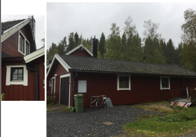
Fasad 3 höger fasad, sett från vägen.
