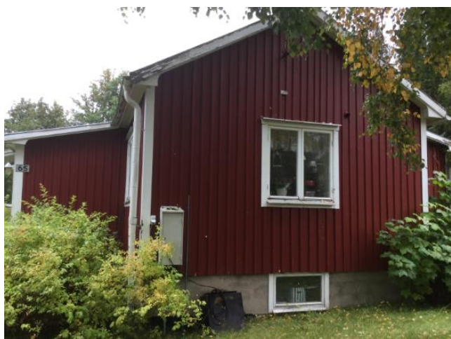
Fasad 3 höger fasad, sett från vägen.
