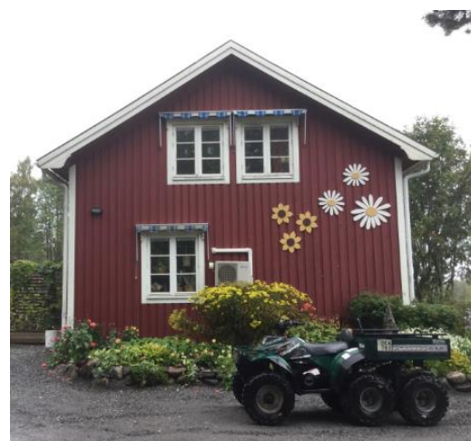
Fasad 4 vänster fasad, sett från vägen.
