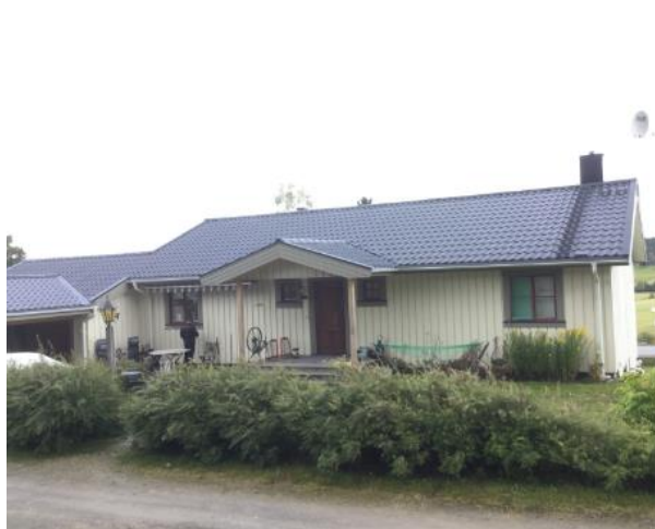
Fasad 2 baksida, sett från vägen
