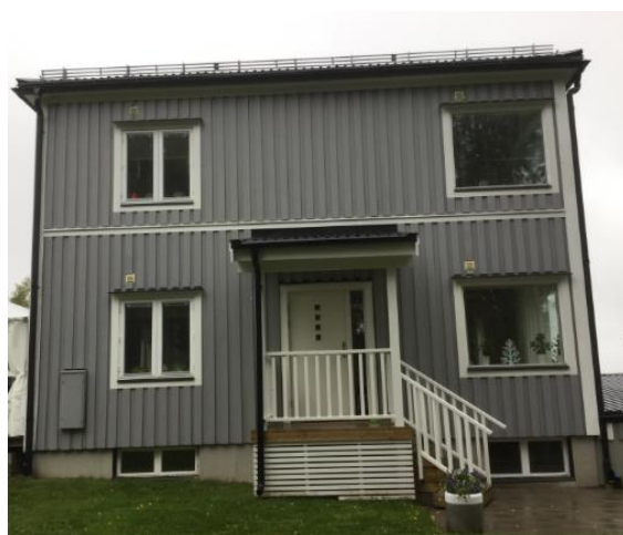
Fasad 4 vänster fasad, sett från vägen.
