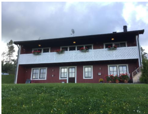
Fasad 1 fasad mot väg 363
