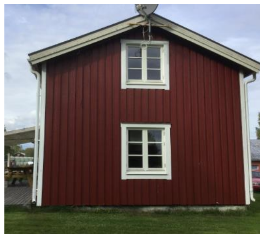
Fasad 4 vänster fasad, sett från vägen.
