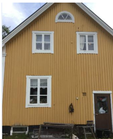
Fasad 3 höger fasad, sett från vägen.
