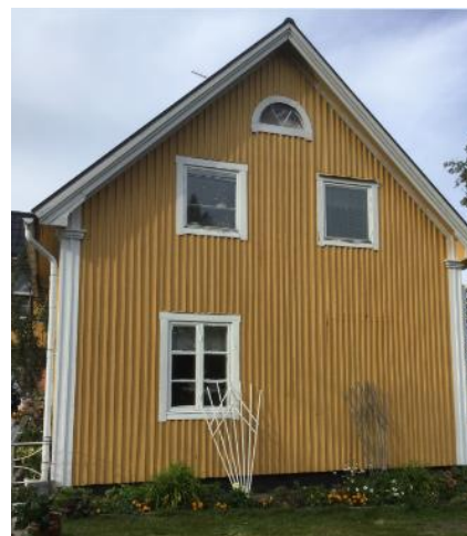
Fasad 4 vänster fasad, sett från vägen.
