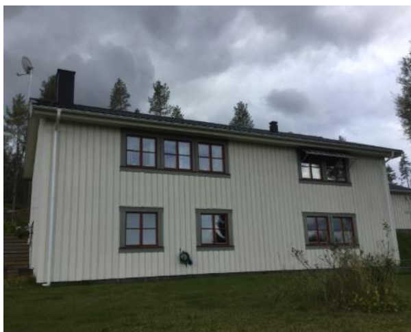
Fasad 1 fasad mot väg 363
