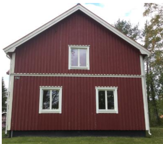
Fasad 1 fasad mot väg 363
