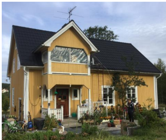
Fasad 2 baksida, sett från vägen
