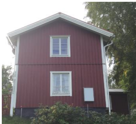
Fasad 1 fasad mot väg 363
