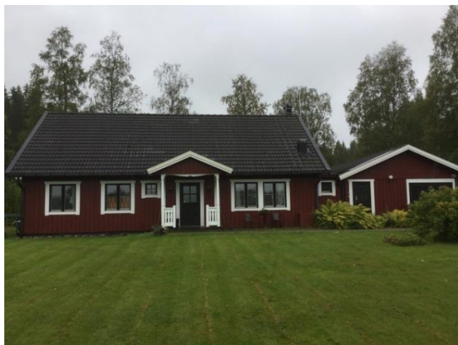
Fasad 1 fasad mot väg 363
