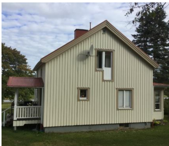
Fasad 2 baksida, sett från vägen
