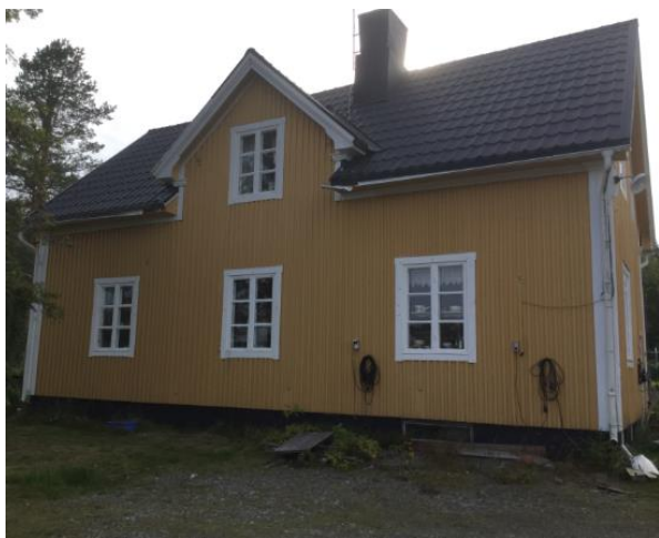
Fasad 1 fasad mot väg 363
