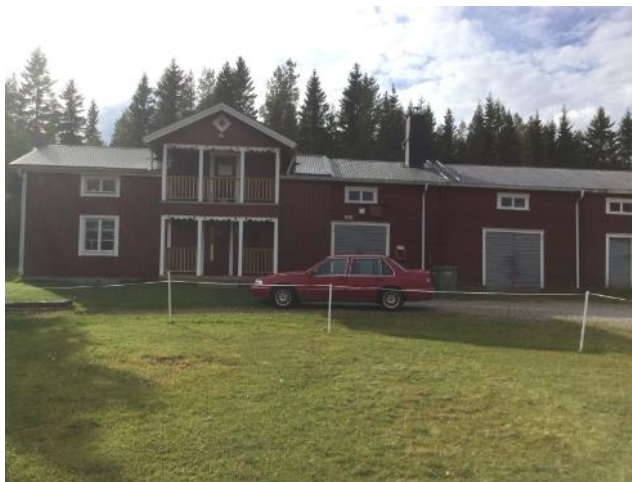
Fasad 1 fasad mot väg 363
