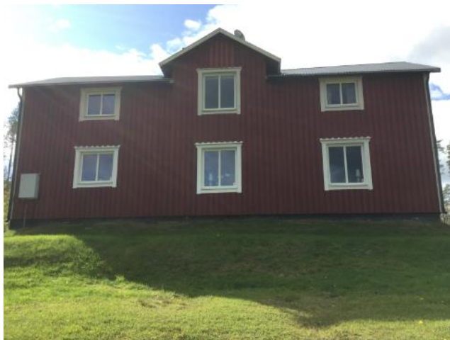
Fasad 1 fasad mot väg 363
