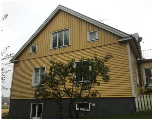
Fasad 3 höger fasad, sett från vägen.
