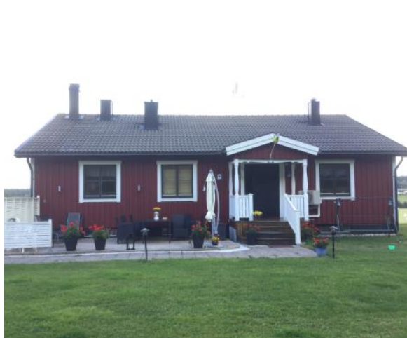
Fasad 2 baksida, sett från vägen
