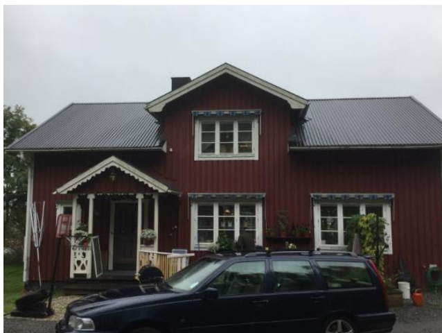
Fasad 2 baksida, sett från vägen
