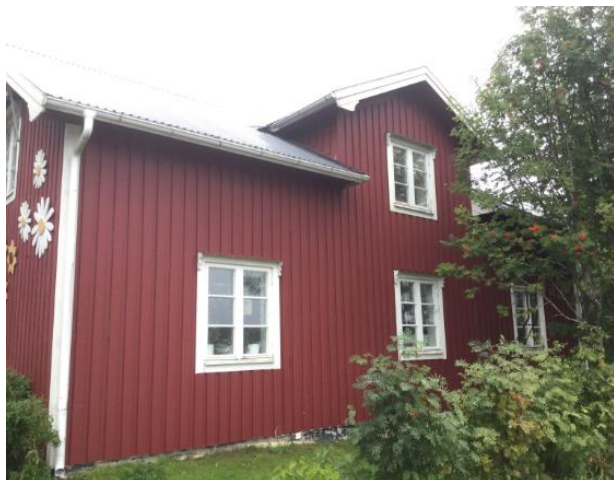
Fasad 1 fasad mot väg 363
