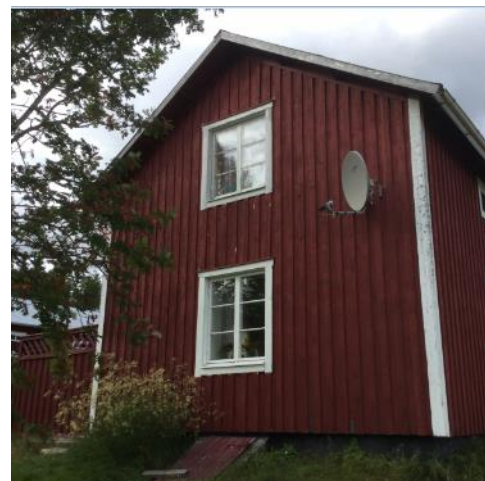
Fasad 4 vänster fasad, sett från vägen.
