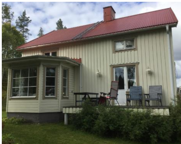
Fasad 4 vänster fasad, sett från vägen.
