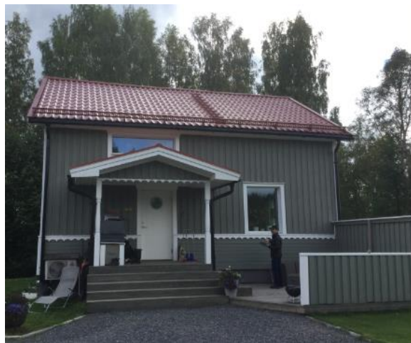
Fasad 4 vänster fasad, sett från vägen.
