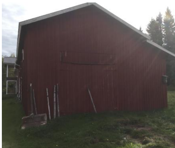
Fasad 3 höger fasad, sett från vägen.
