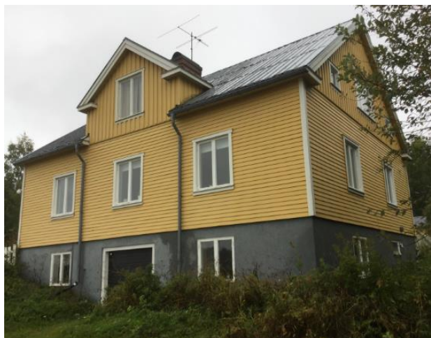
Fasad 1 fasad mot väg 363
