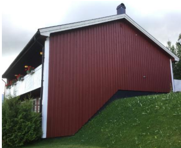
Fasad 3 höger fasad, sett från vägen.
