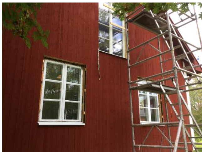
Fasad 1 fasad mot väg 363 (Ö)
