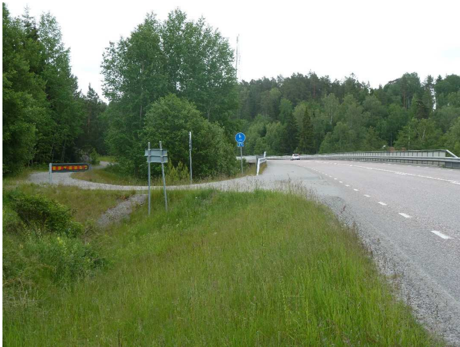
Bild 3 Anslutande cykelväg i söder vid Ingaröbron.
