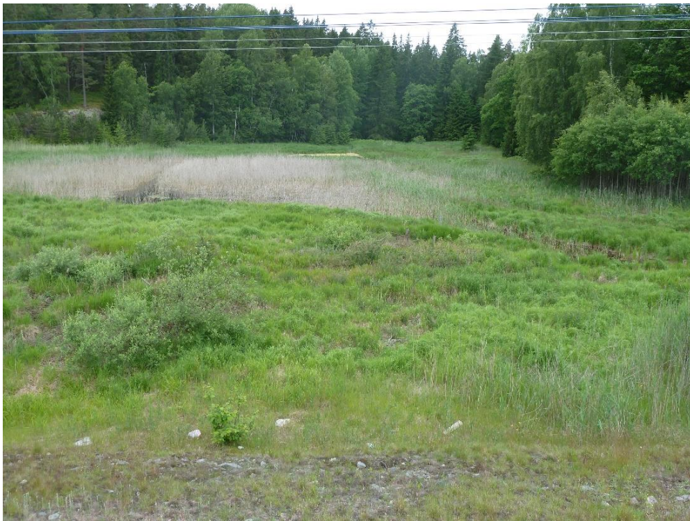
Figur 9-10 Dike som kulverterats under väg 646. Den övre bilden visar diket öster om vägen och den nedre väster om.
