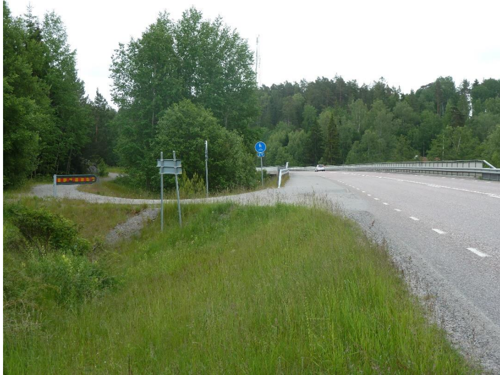
Figur 12 Anslutande gång- och cykelväg i söder vid Ingaröbrons norra fäste.
