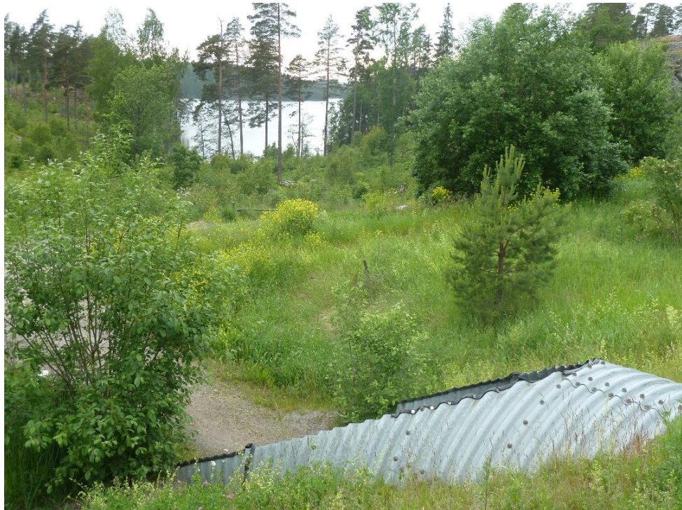
Figur 18. Rörbro strax söder om Lämshagakorset. Vy väster om väg 646. Sjön Långträsket syns i bakgrunden.
