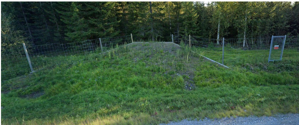
Figur 13. Exempel på viltuthopp på E4.
