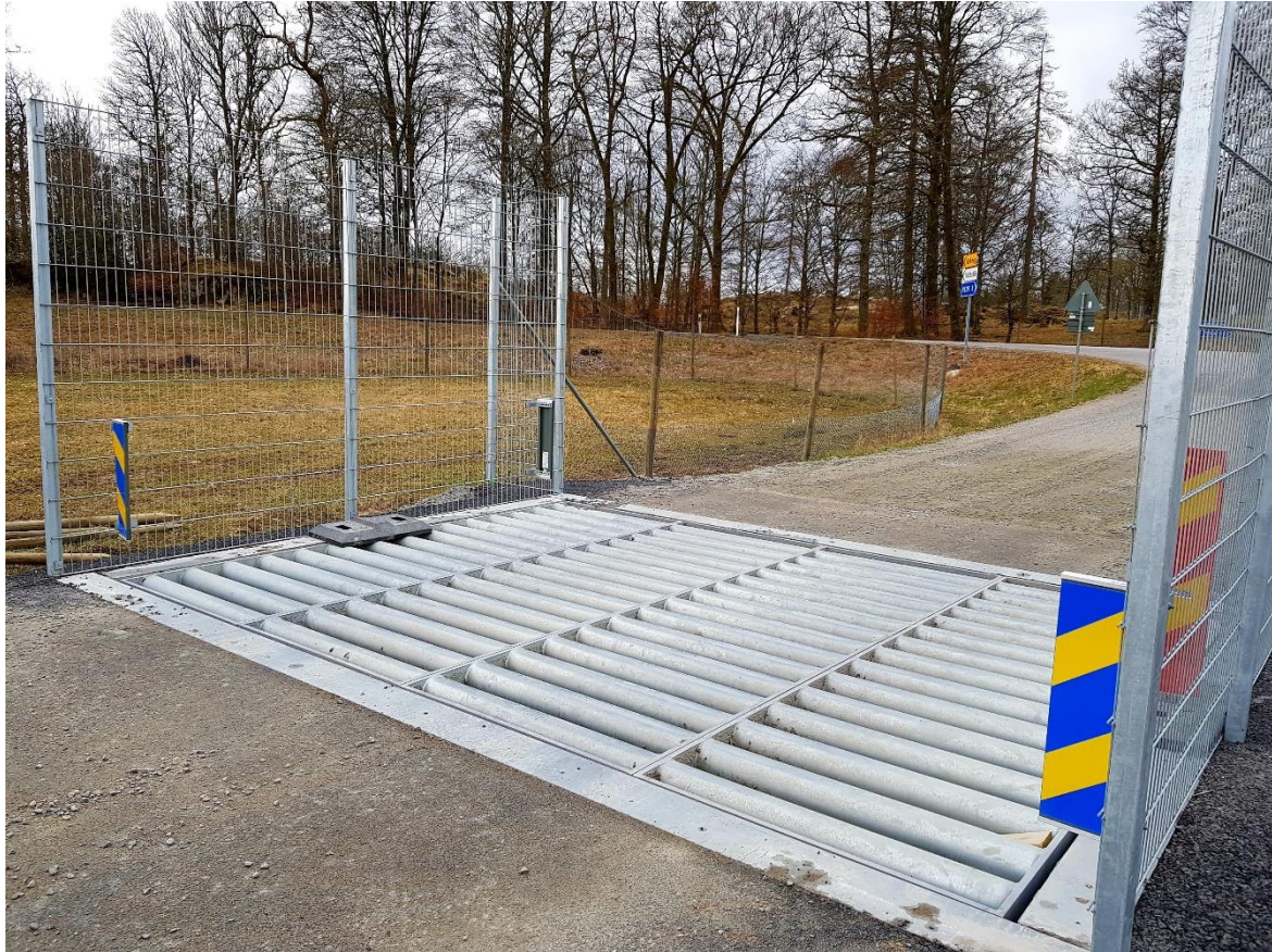
Figur 16. Exempel på utformning av nyanlagd färist vid anslutning till väg 42, Trollhättans kommun. Foto Fredrik Winterås.
