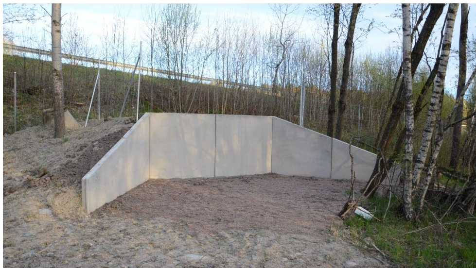
Figur 37: Uthopp vid Sagsjön, E6 söder om Göteborg. Foto: Mattias Olsson
