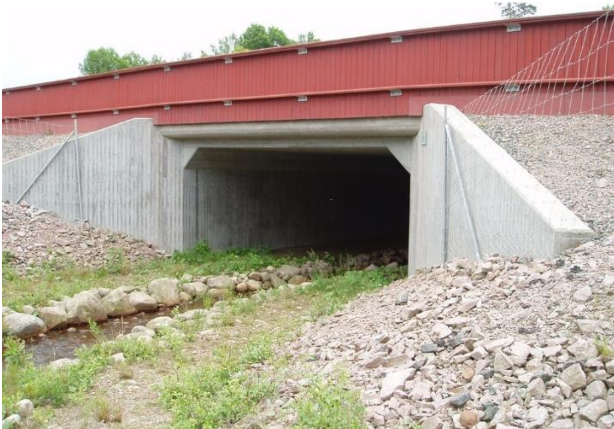
Figur 35: Faunaport kombinerad med bullerskärm för att minska störningar från trafiken. Bild från faunapassage utmed väg 49 mellan Skara och Skövde.
