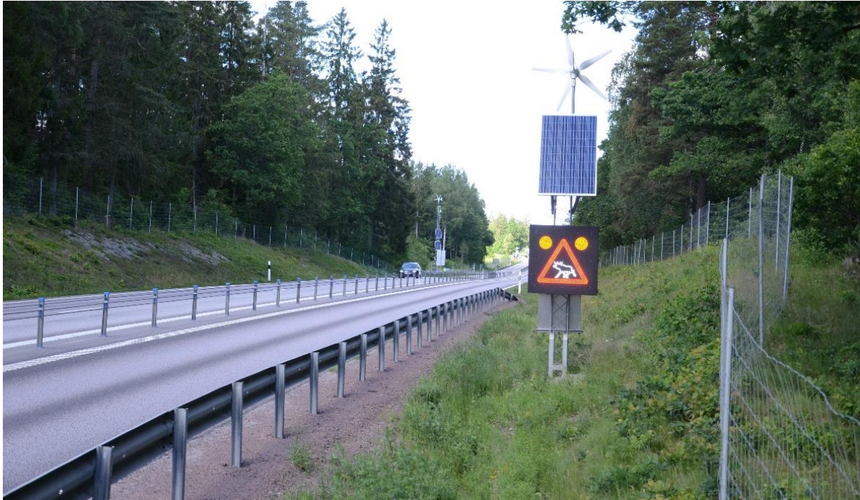
Figur 32: VMS-skyltar med t ex älgsymbol ska aktiveras när vilt är i faunapassagen och därmed varna bilister. Foto från Haraldsmåla E22, faunapassagen ligger ca 250 m bortanför VMS-skylten. Foto: Mattias Olsson.
