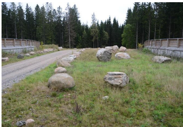
Bild 7. Väg 27, faunabro kombinerad med enskild väg, söder om Borås.
