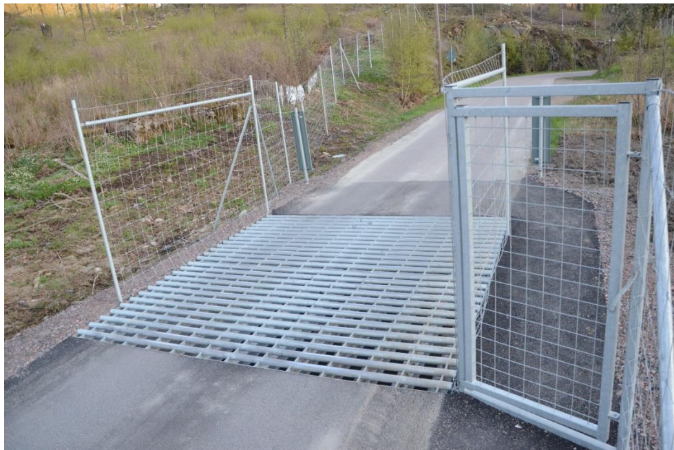
Figur 36: Färister vid anslutande väg för att minska risken att älg tar sig in på E6. Vid sidan om färisten finns en gånggrind Foto: Mattias Olsson.
