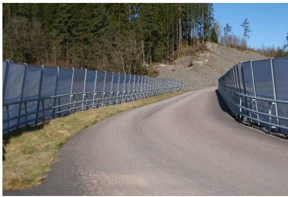
Bild 5. E45, vid Alafors finns en breddad konventionell bro med skärmar samt gräsytta intill ena kanten av bron.
