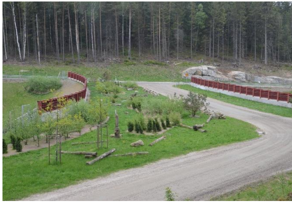
Bild 3. E45, faunabro kombinerad med enskild väg, vid Bliksered, strax söder om Lilla Edet.
