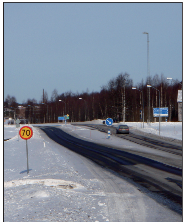
E4 vid löfvånger. Korsning väg 750/753 och E4.
