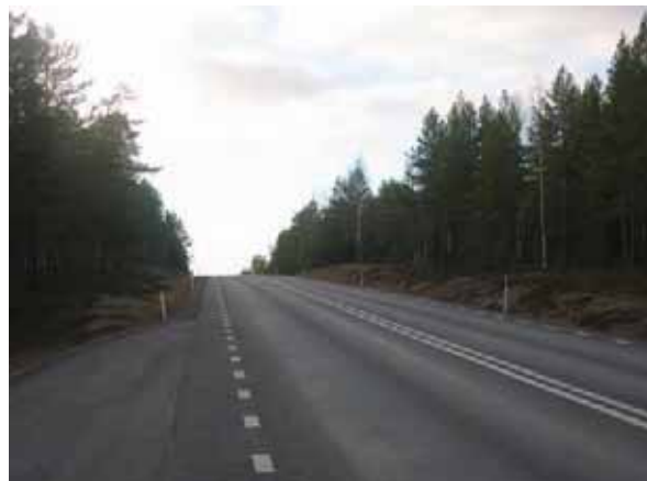
Figur 3.2: Delar av vägvägningsdelen har påtagliga brister i siktförhållanden. Bilden är tagen norr om Granberget (Nr 11 i karta 4.6).
