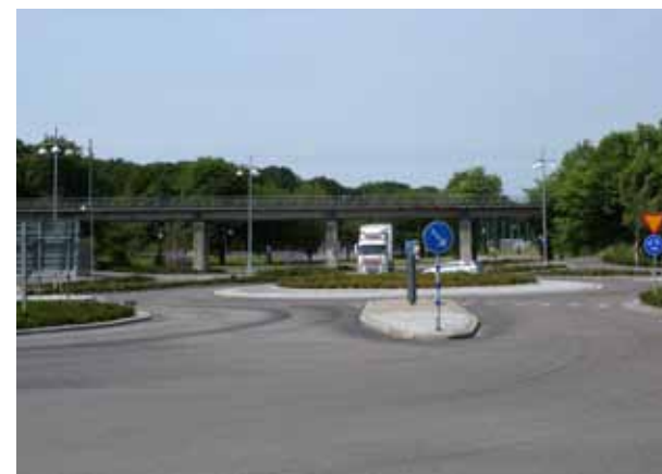
Figur 4.16 Befintlig järnvägsbro över Säterigatan.
