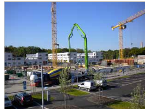
Figur 4.12 Pågående byggnation i Västra Eriksberg.
