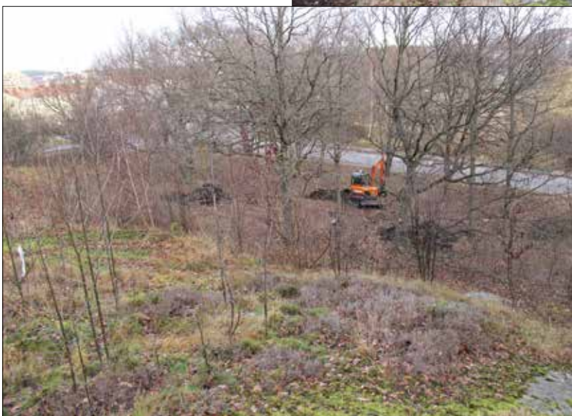
Figur 6. Översikt mot den norra delen av Göteborg 494. Bratteråsgatan syns i bildens övre del, strax invid gräv-maskinen. Foto: Jörgen Streiffert.
