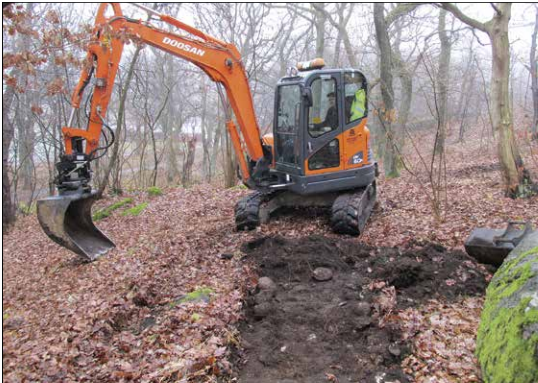
Figur 9. Vår grävmaskinist Tobias Bergqvist tar här fram ett av de schakt som upptogs inom Göteborg 493. Foto: Jörgen Streiffert.
