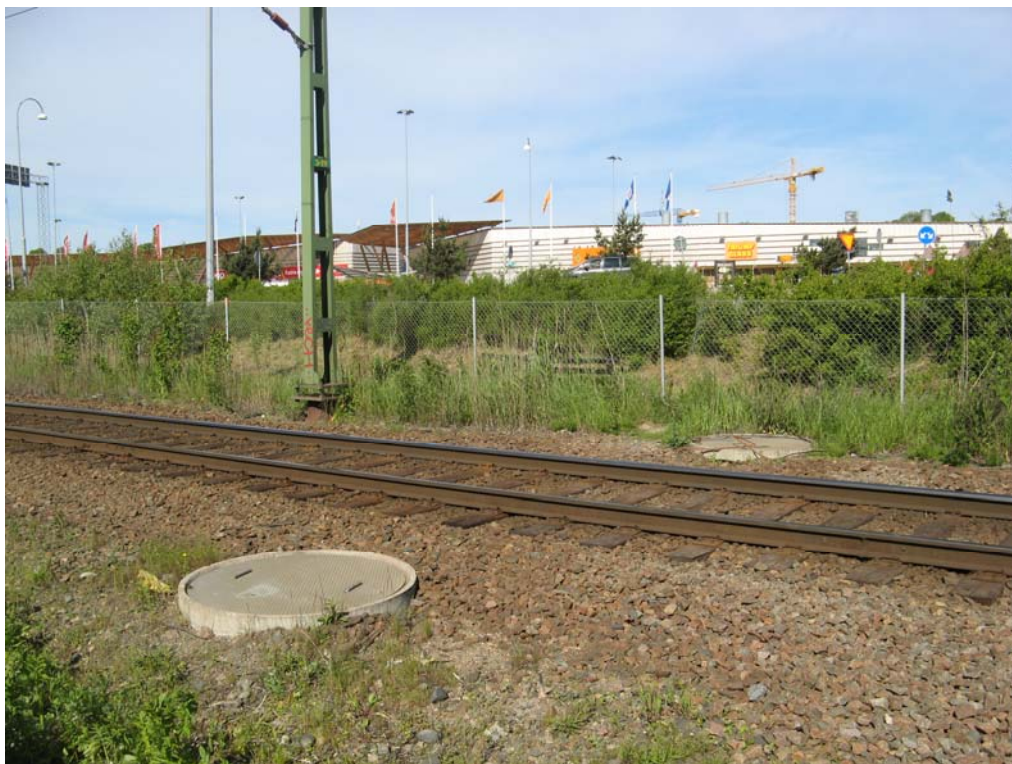
Bild tagen vid ca km 4+000 i nordvästlig riktning mot Kolhamnsgatan
