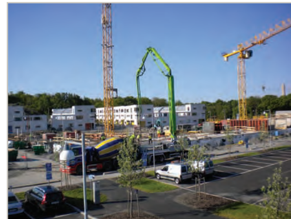
Figur 4.12 Pågående byggnation i Västra Eriksberg.
