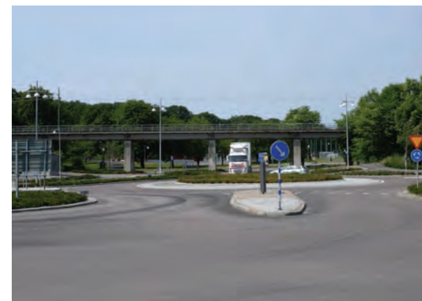
Figur 4.16 Befintlig järnvägsbro över Säterigatan.
