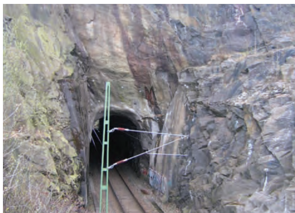
Figur 4.15 Befintlig tunnel genom Bratteråsberget.
