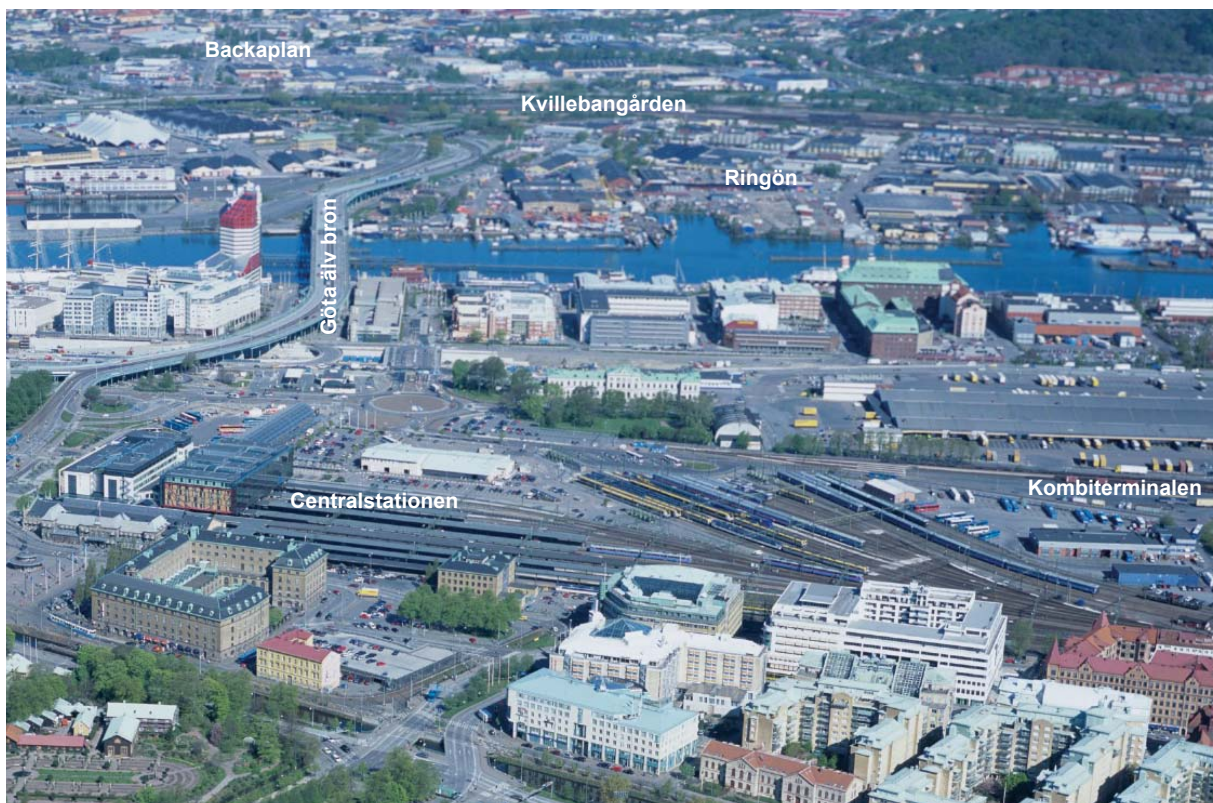
Figur 6.2.1: Gullbergsvass med Centralstationen samt dagens kombiterminal. Bortom älven skimtar Ringön, Kvillebangården och Backaplan. Foto: Flygare Palmnäs 2005
