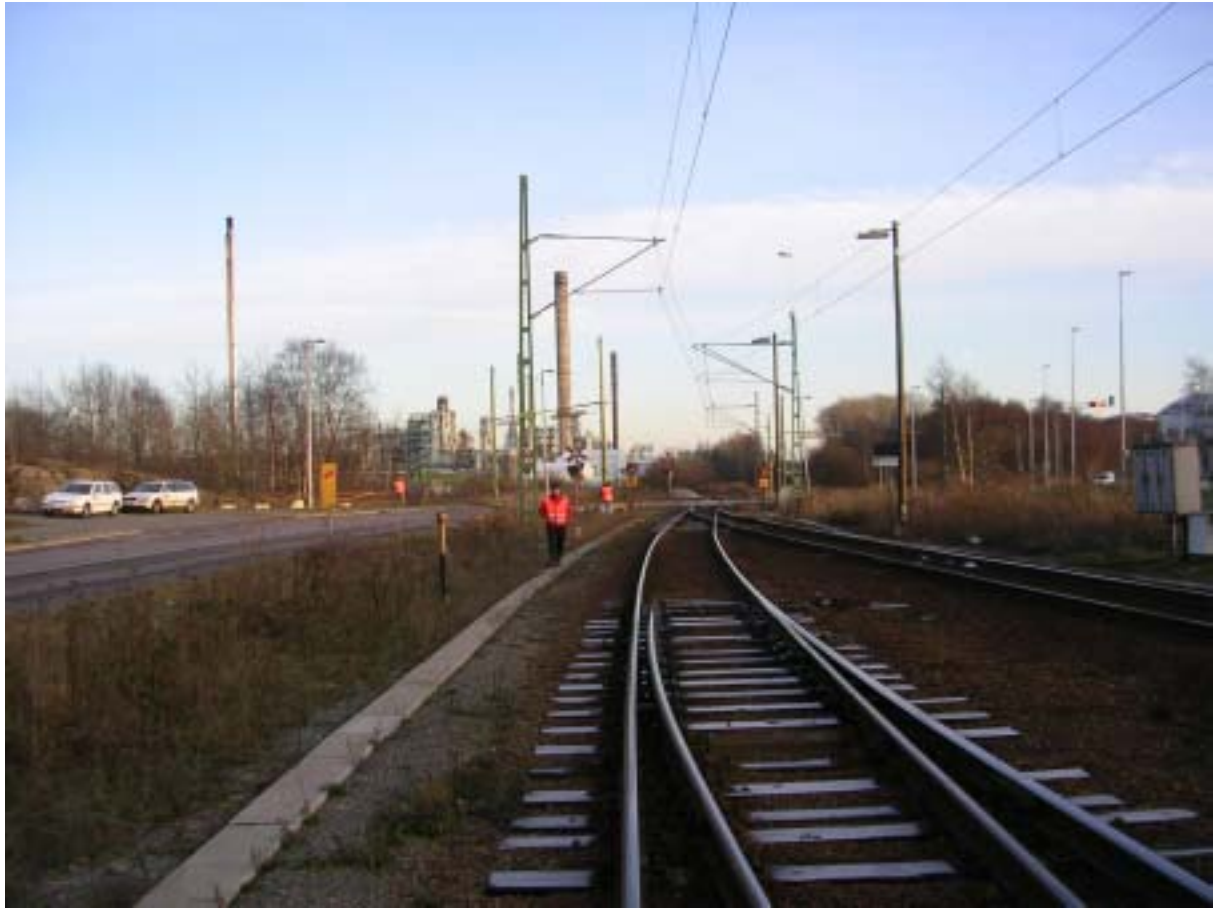
Figur 23 Växeln till utdragsspåret föreslås vid plåtskåpet i högra bildkanten och spåret fortsätter på högra sidan om kontaktledningsstolparna.
