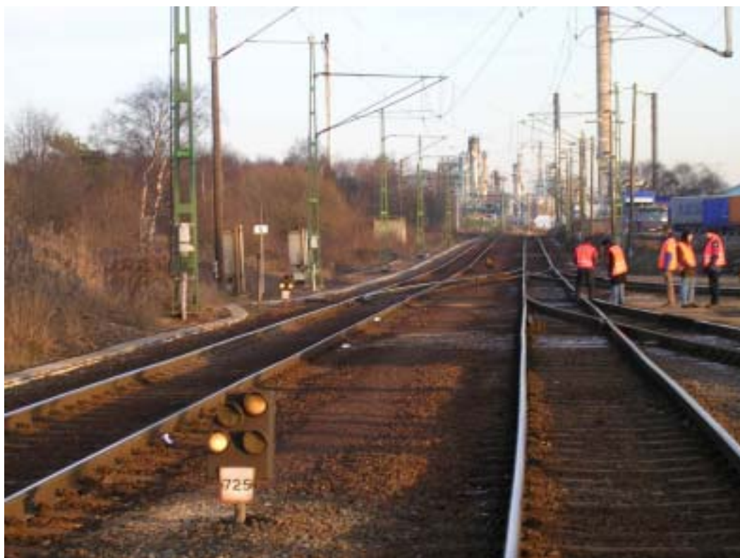
Figur 3 Växelpar 713-714 förbinder spår 1 och 2. Växelparet föreslås vändas.
