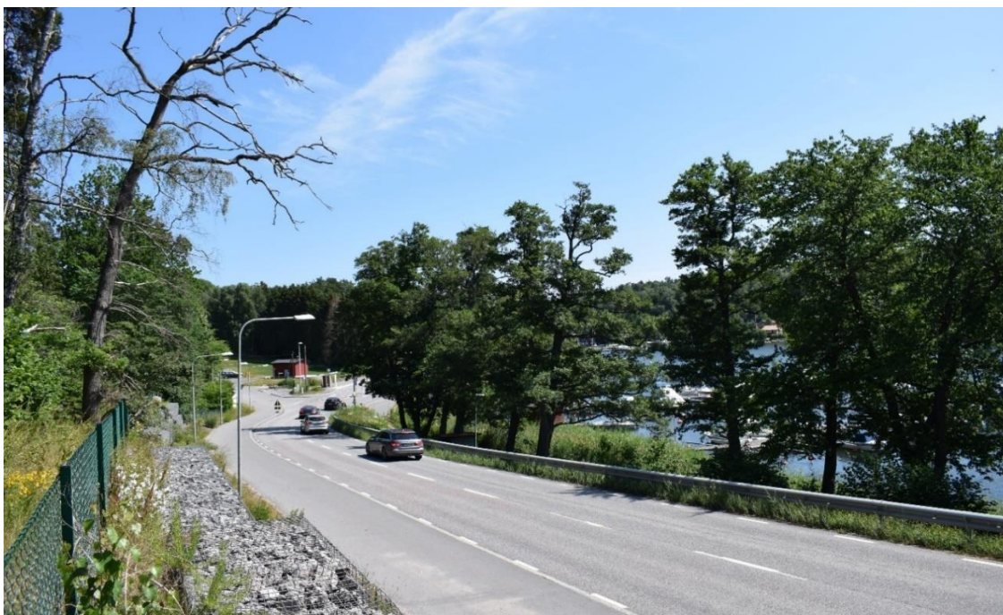
Figur 8. Vy mot öster från väg 222. Notera träden som begränsar sikten till busshållplatsläget Strömma kanal mot Sollenkroka.
