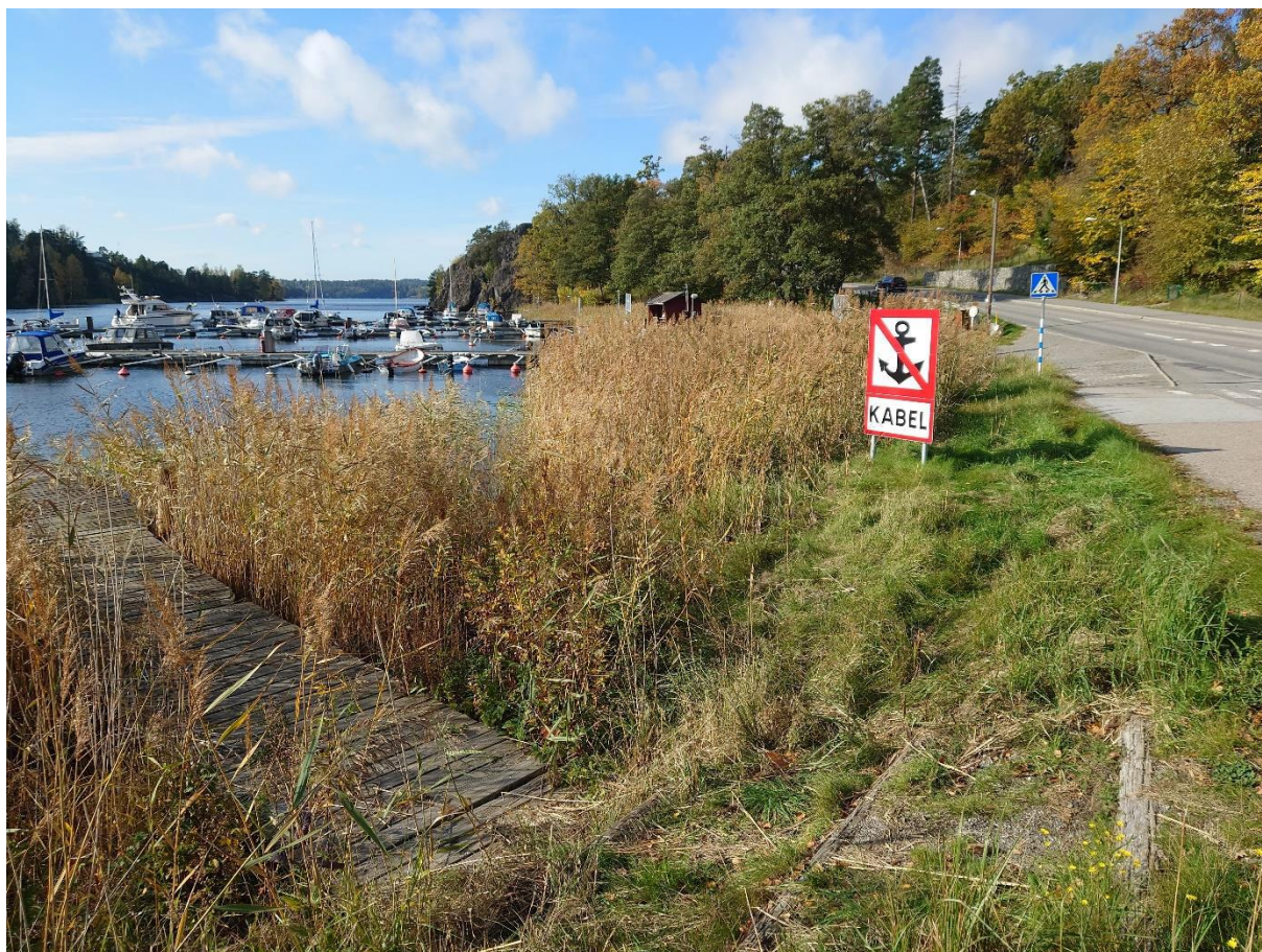
Figur 18. Vy mot väster på strandremsan utmed småbåtshamnen i Strömma.
