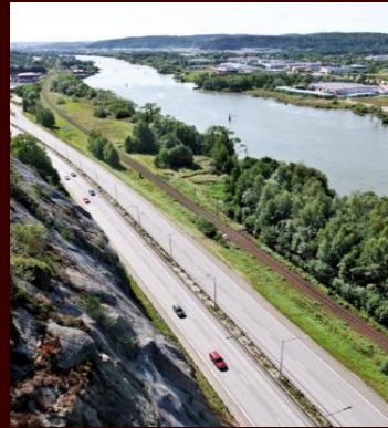
Planering och byggande av ny infrastruktur
