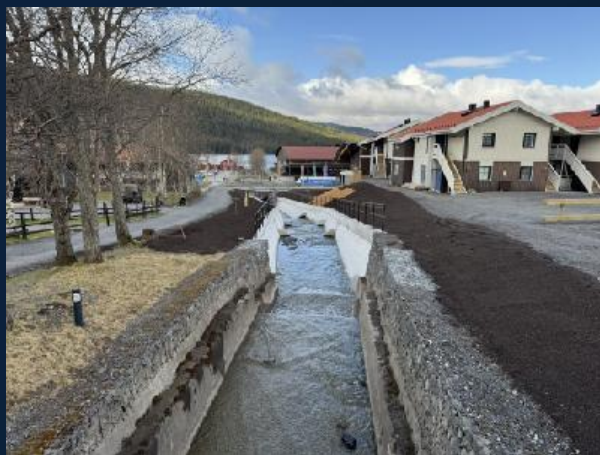
Erosion och översvämningsskydd Mörviksån Åre
