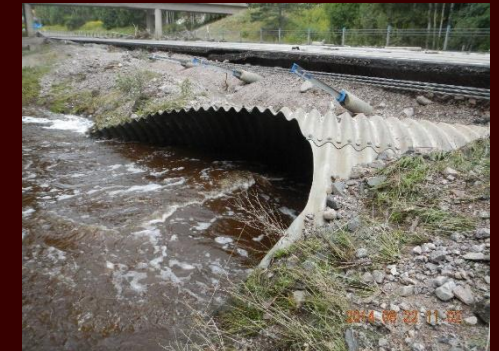
Utbyte av anläggningsdelar, vidmakthållande
