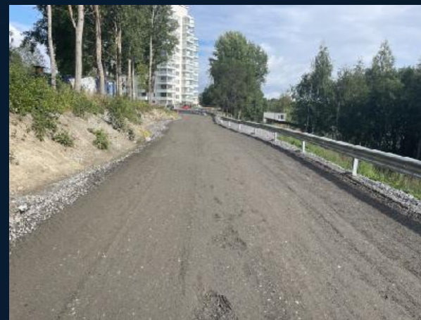
Skredsäkring Kvarnvägen Umeå
