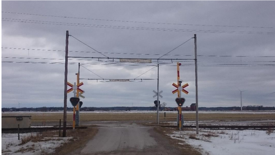
Bild 4 Ungefärlig utformning av elskyddsportal.
