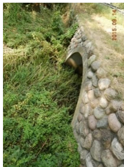
Figur 20. Befintlig vägbro, 12-528-1, över bäck.
