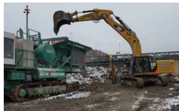
Figur 48. Bortsprängt berg krossas och återanvänds i vägbyggnaden
