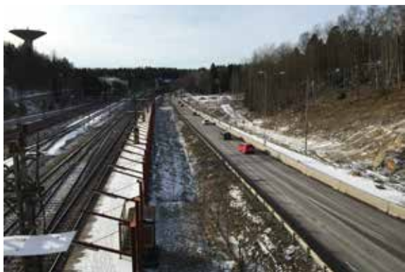
Figur 24. Utsikt från gångbron vid Flemingsbergs station. Byggnation pågår (foto taget februari 2016).
