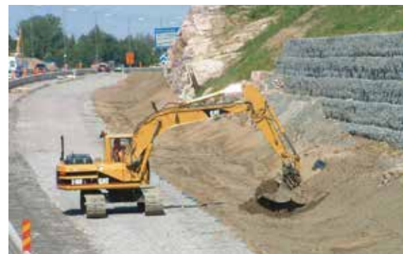
Figur 47. Trafiken flyttas för att den nya väghalvan ska kunna byggas.
