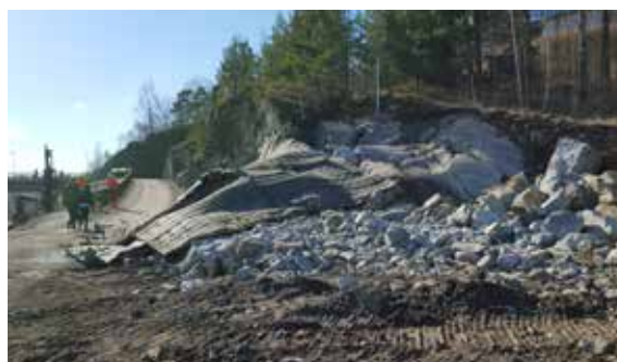
Figur 49. På känsliga platser läggs så kallade sprängmattor ut för att förhindra stensprut
