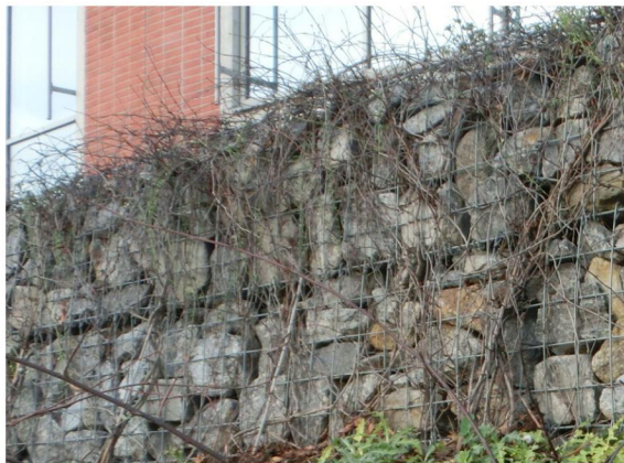
Gabinmurarna fylls med utvald sten i större storlekar för att ge ett jämt intryck
