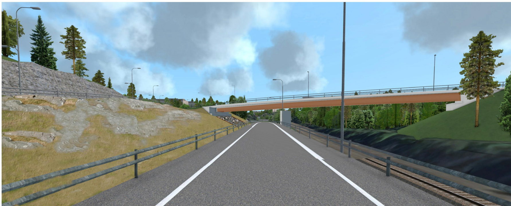
Den framsprängda bergytan i kilen mellan vägtorna återfylls med mineraljord och besås med ängsgräs. I fonden bildar bron över pendeltåget en tydlig port in till nästa trafikrum
