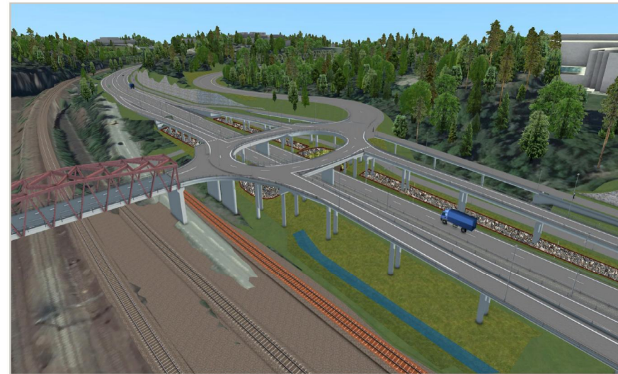
Ovan: Den förslagna upphöjda trafikplatsen med ramper på pelare och ordnade ytor under ramperna, skiss/samordningsmodell, WSP
