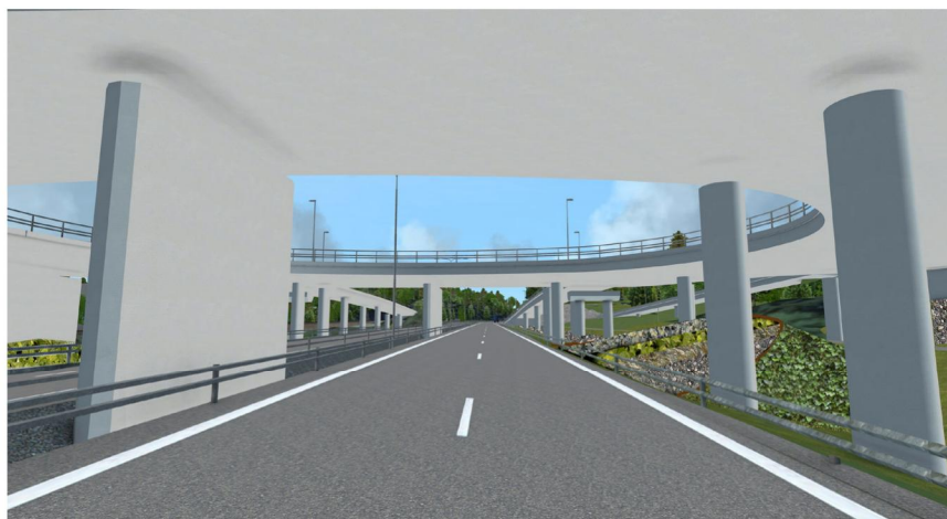
Ovan: Markytan som i plan begränsas av cirkulationen gestaltas med två svagt sluttande halvcirklar. Ytorna avgränsas med kanter i cortenstål och beläggs med fält av sprängsten och sedum.
