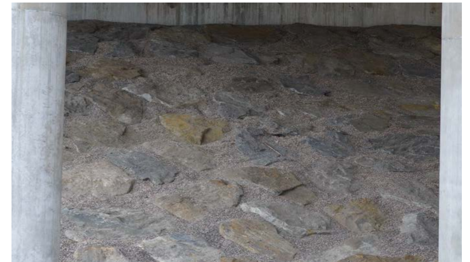
Fig. 51. Exempel på stensättning under bro.
