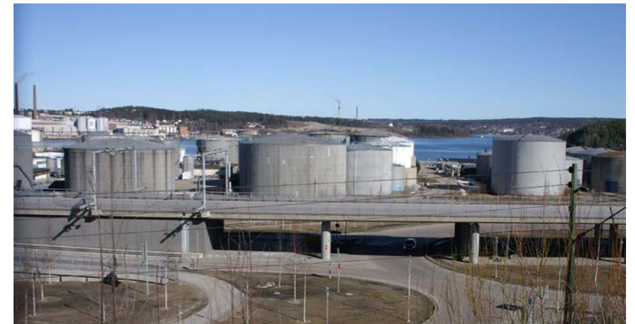
B Oljehamnen med sina cisterner ligger vid inloppet till Sundsvall och är ett landmärke för de som närmar sig staden från vattnet eller från E4. På bilden syns även trafikplats Skönsmon och E4.
