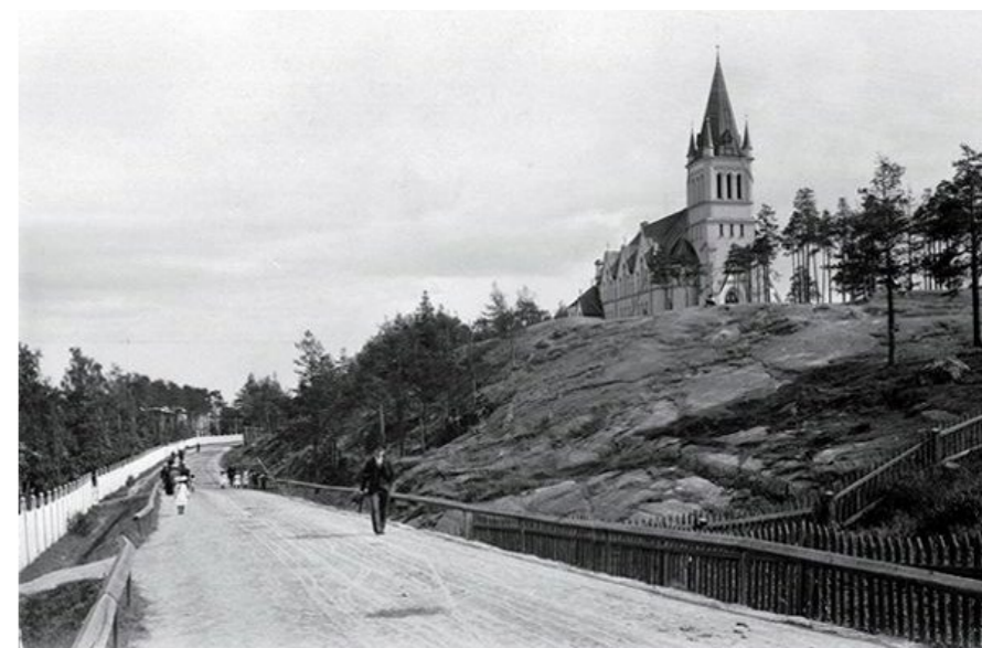
Figur 11. Skönsmons kyrka är byggd på berg i dagen. Aktuell sträcka av järnvägen anlades på en tidigare väg som syns på fotografiet. Foto från Digitalmuseum.se
