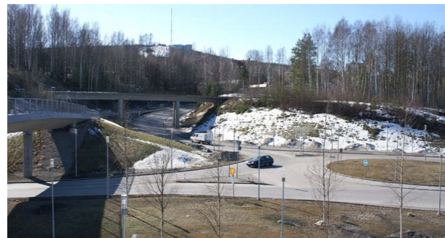
Fig. 22. Området kring Skönsmons trafikplats är gestaltat med flertalet björkar samt stödmurar med gabioner.
