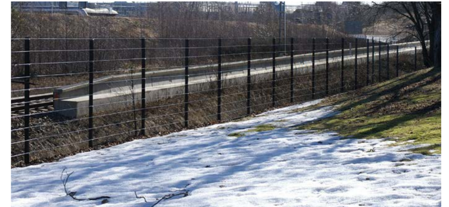
Fig. 45. Personskyddsstängsel anpassas efter befintligt i Kubikenborg.
