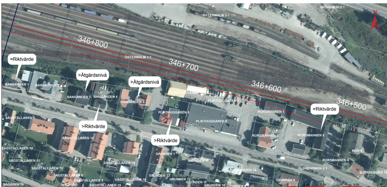
Figur 8.6:2 Nollalternativet. Byggnader vid Björneborgsgatan väst, km 346+470 och km 346+900, som bedöms få vibrationsnivåer över riktvärde eller åtgärdsnivå för befintlig infrastruktur.
