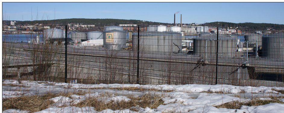
Figur 8.1:3 Oljehamnen och E4/södra landfästet till Sundsvallsbron skymtar genom järnvägsstängslet. Vy från Sönderborgsgatan.
