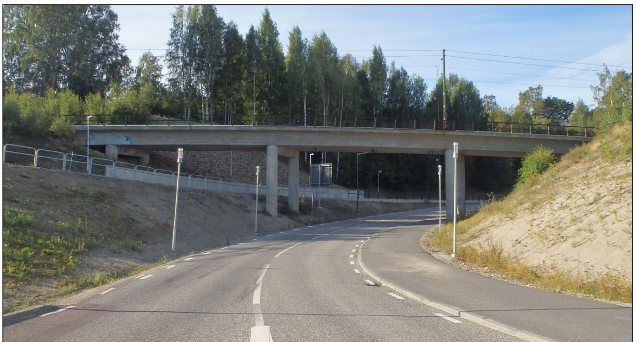
Figur 6.2:7 Befintlig järnvägsbro över allmän väg E14/Björneborgsgatan. Bron föreslås att rivas i och med att ny bro byggs för dubbelspår. Foto: BaTMan.
