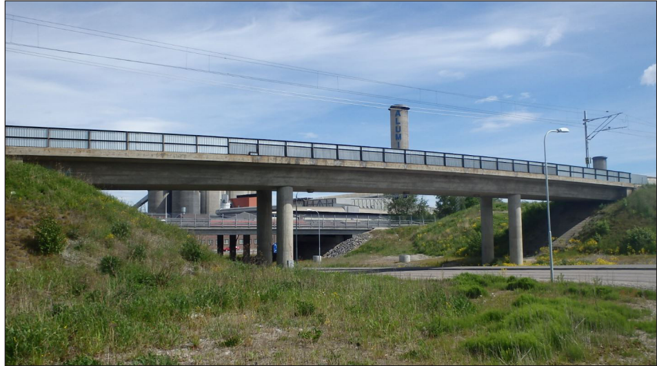
Figur 3.3:4 Bro över kommunal gata Fridhemsgatan. Foto: BaTMan.
