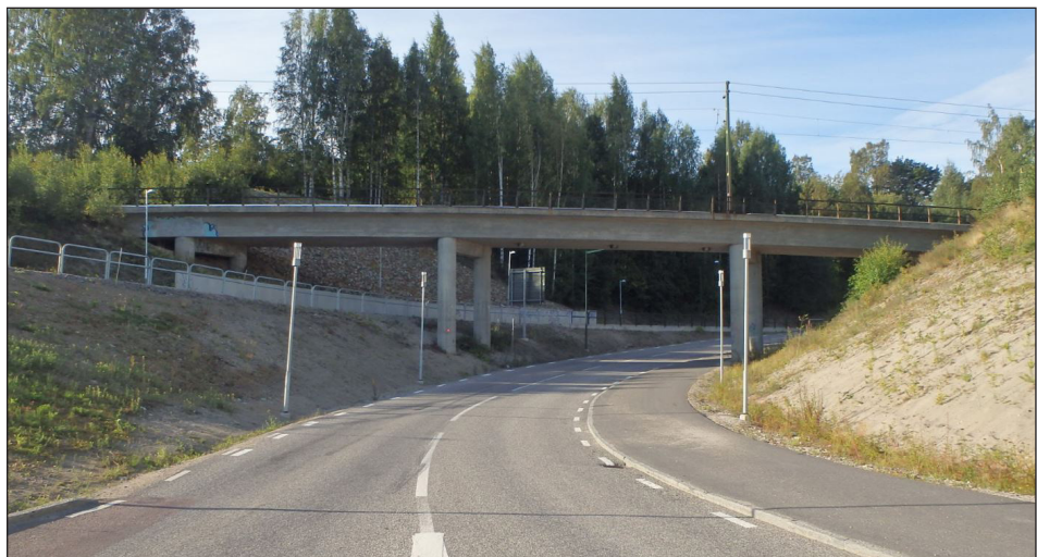
Figur 3.3:5 Bro över allmän väg Björneborgsgatan. Foto: BaTMan.
