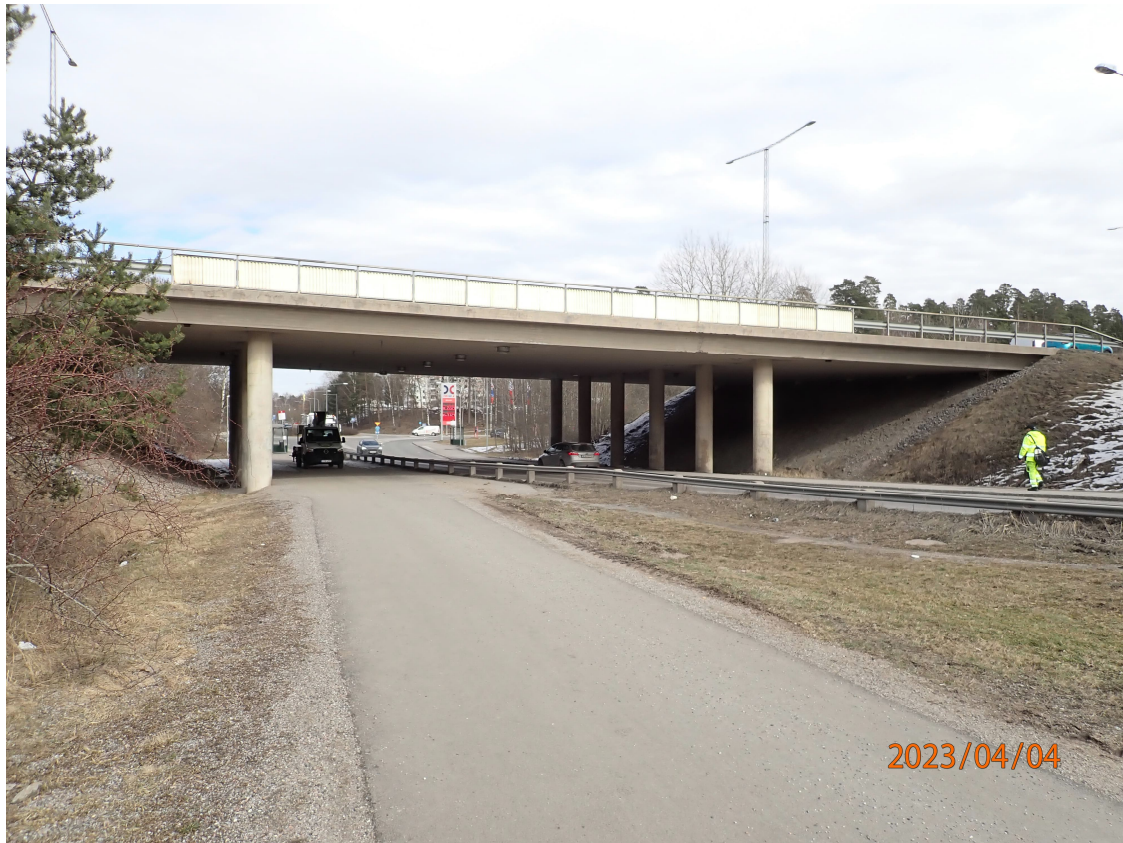
Figur 4 visar bro 2-1000-1, vy mot norr. Källa: BaTMan.
