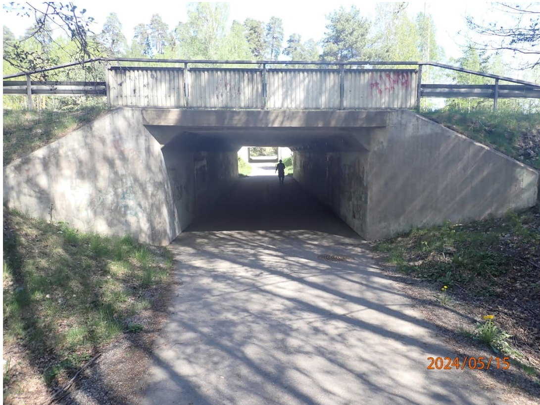
Figur 5 visar Bro 2-1001-1, vy mot norr. Källa: BaTMan.
