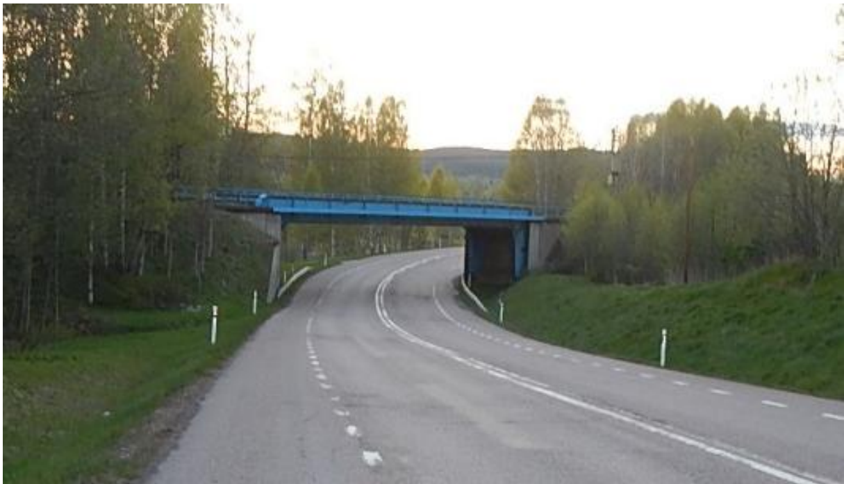
Figur 21. Befintligt byggnadsverk, som är en järnvägsbro i Duvnäs.
