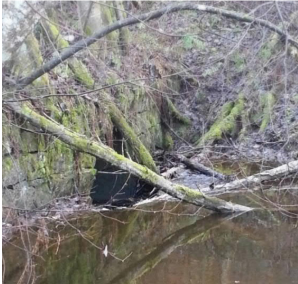
Figur 18. Visar exempel på att trummor för genomledning av vatten är undermåliga; här trumma med fördämt inlopp till trumma vid Broängsbäcken.
