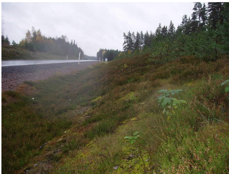
Figur 17. Vägslänt i skogslandskap med naturlig återetablering i avbaningsmassor.
