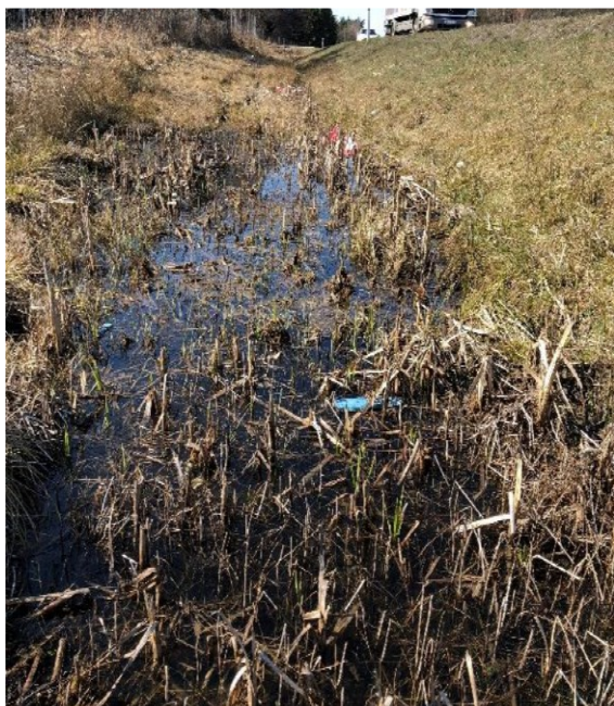
Figur 20. Lekvatten 2 i det fördjupade diket längs med väg 678.
