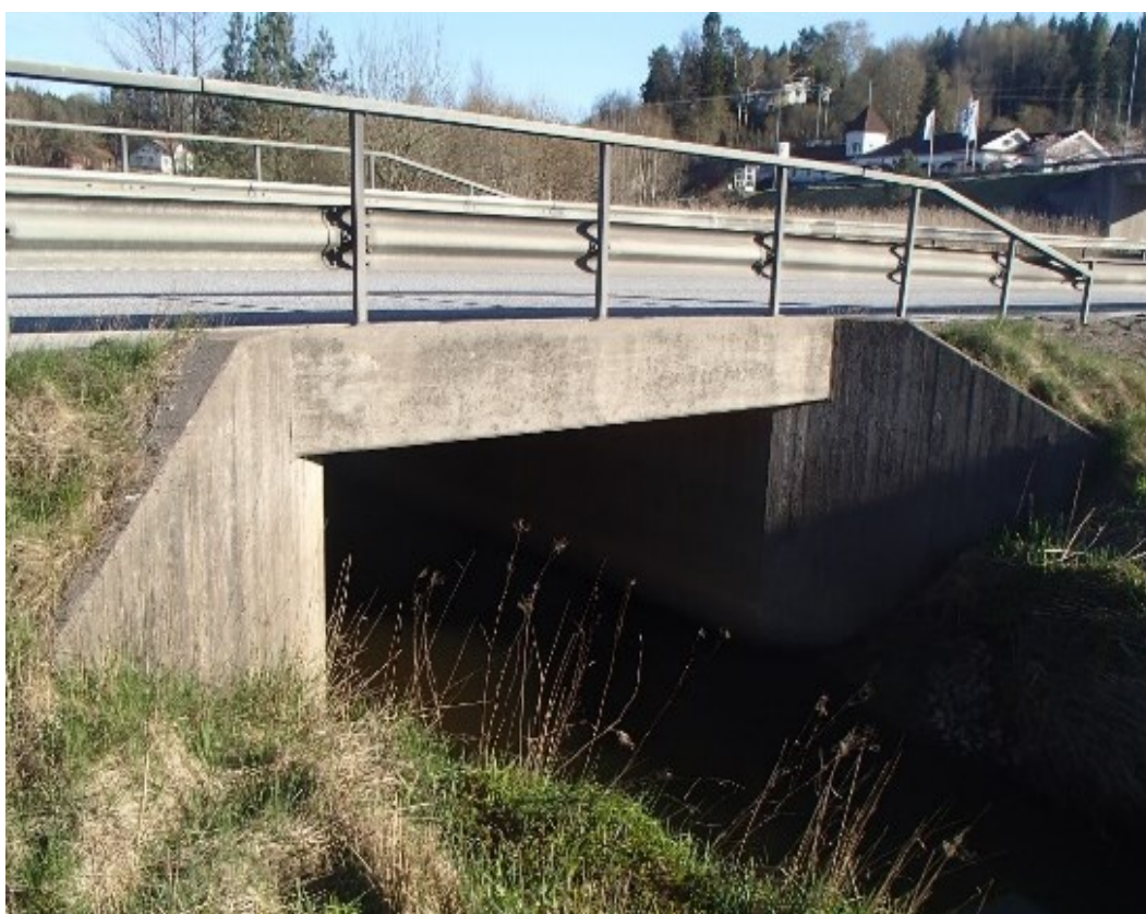
Figur 30. Bro över Bodeleån vid hållplats Bratteröd.
