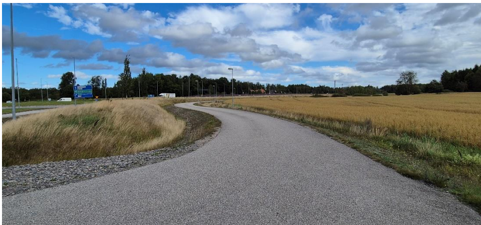
Figur 2. Vy mot norr i norra slutpunkten sträckan vid Alingsåker. Enskild väg till vilken gång- och cykelvägen planeras att anslutas. (Bild ViaDesign)
