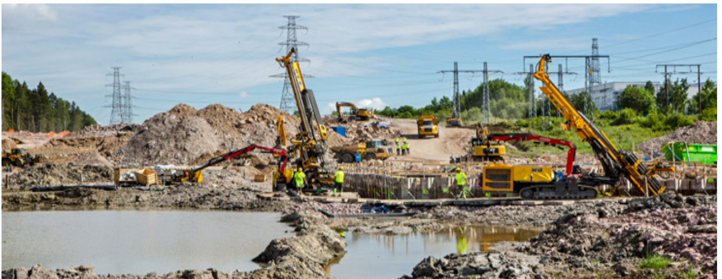
Spontmaskiner, som syns på bilden, kommer att användas under arbetet. Foto: Mikael Ullén
