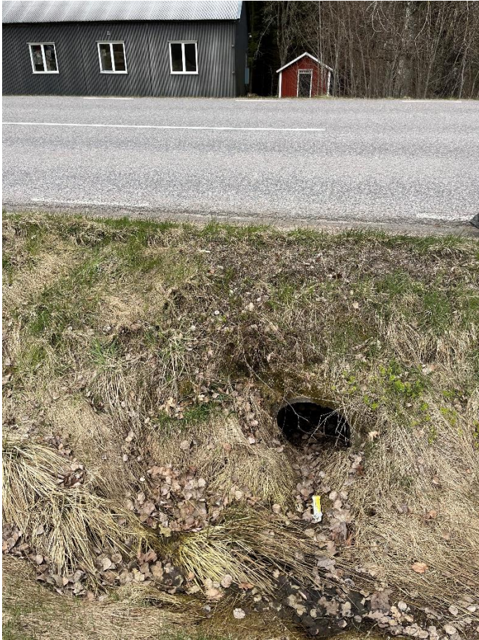
Bild 1. Bilden visar aktuell vägtrumma (källa: AFRY).
