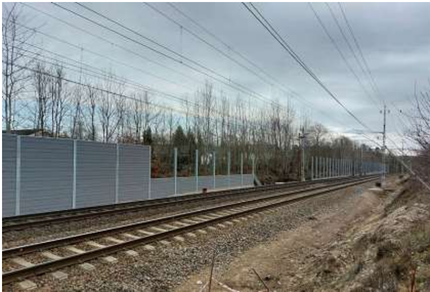
Bild: Anläggning av spårnära bullerskyddsåtgärder
