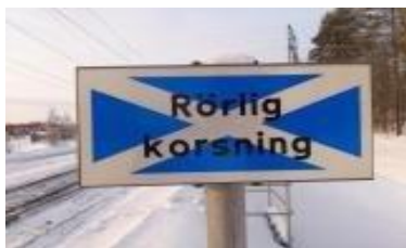
Figur 2 Skylt för spårväxel med rörlig korsningsspets.
