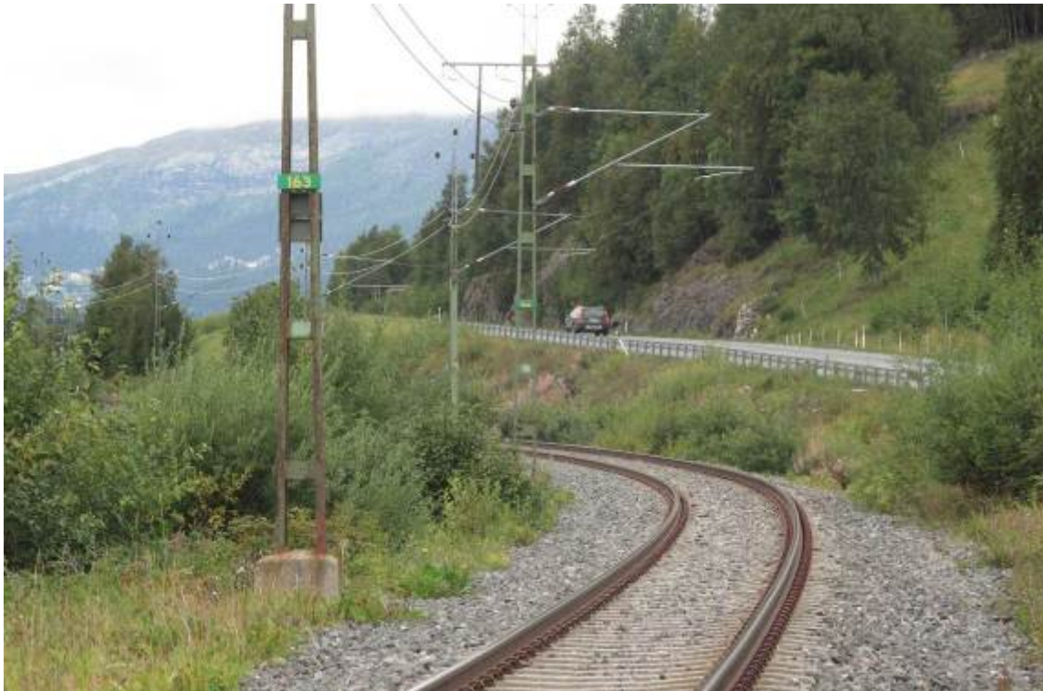
Järnvägen löper bitvis tätt in på E14 på den södra sidan.
