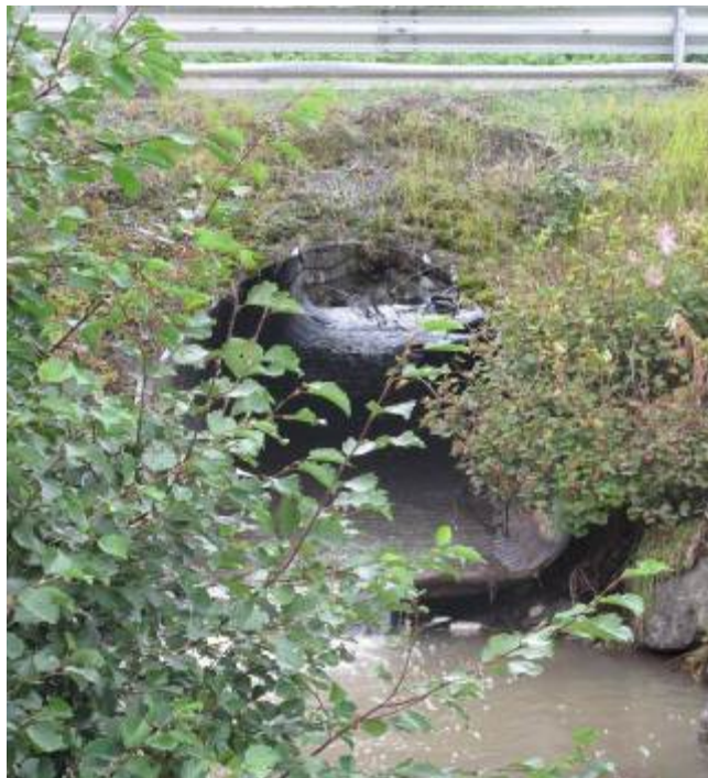
Vikbäcken passerar under E14 genom en så kallad rörbro som utgörs av en trumma med platt botten.
