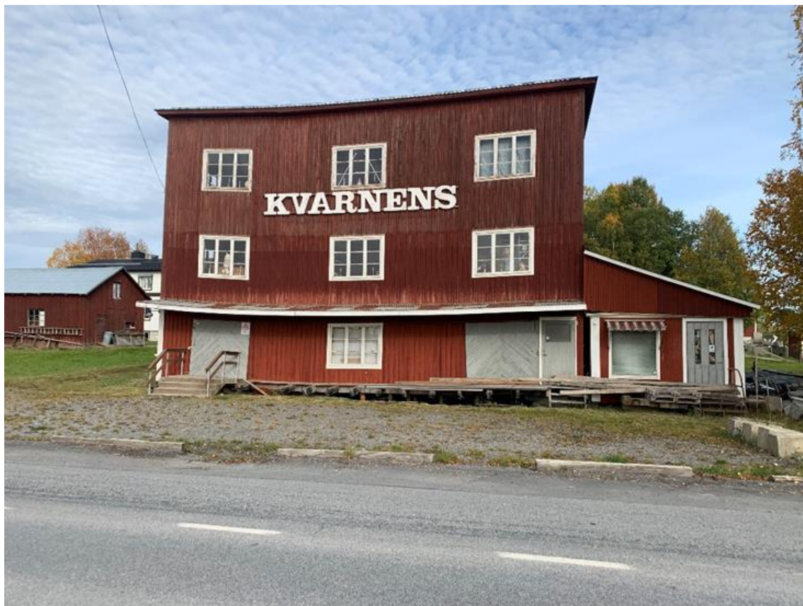
Figur 4.5:1. Utpekad värdebärare för kulturmiljön, kvarnbyggnad på Storgatan 87 i Hammerdal.
