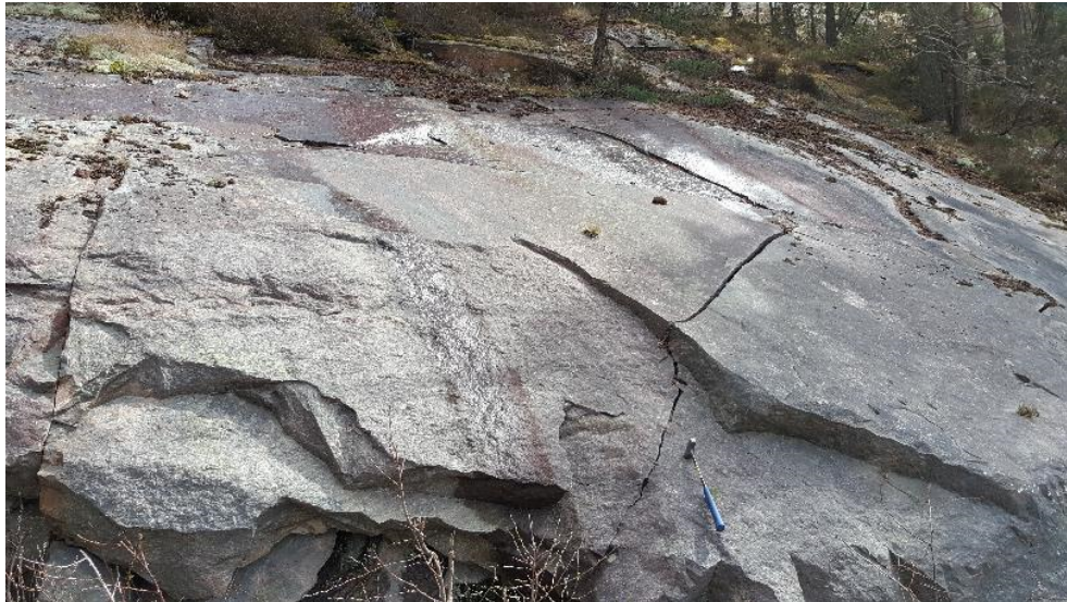
Figur 4 Foto på bergskärning 4 som visar lokala uppsprickningar i berget.
