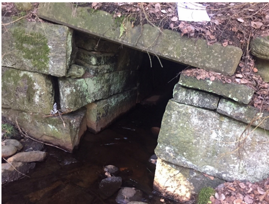
Figur 15. Stentrumman vid passagen över Norra Häcksjöbäcken.
