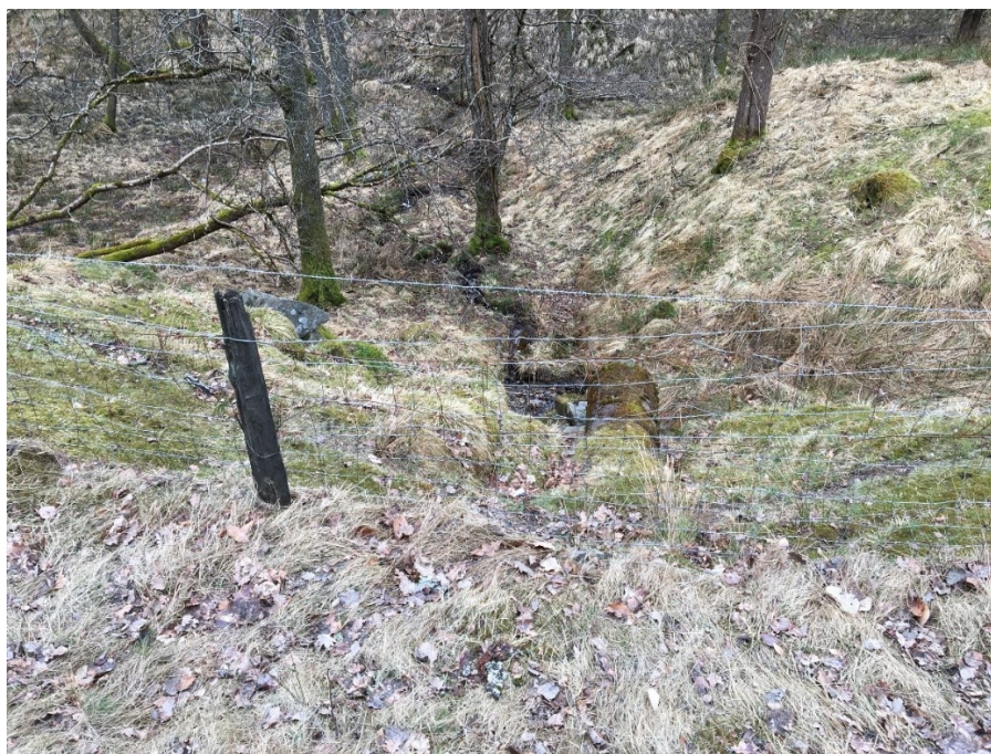
Figur 6. Ravinen går i en dalgång som gränsar till jordbrukslandskap i söder och hällmarkstallskog i norr. I bild syns även den vägtrumma som avrinningsvatten öster om väg 1937 rinner genom under vägen.
