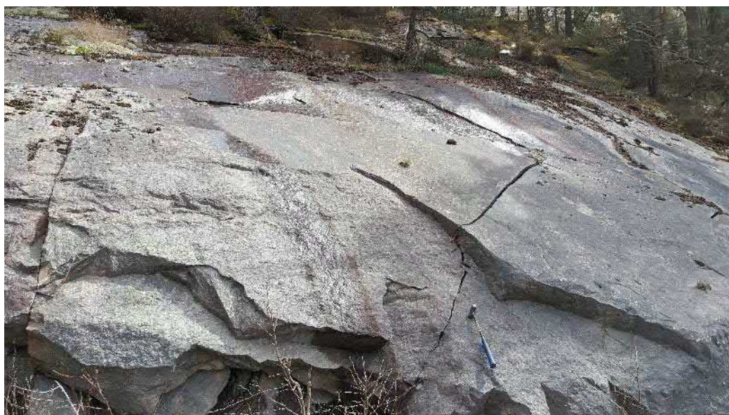
Figur 9 Foto på bergskärning 4 som visar lokala uppsprickningar i berget.
