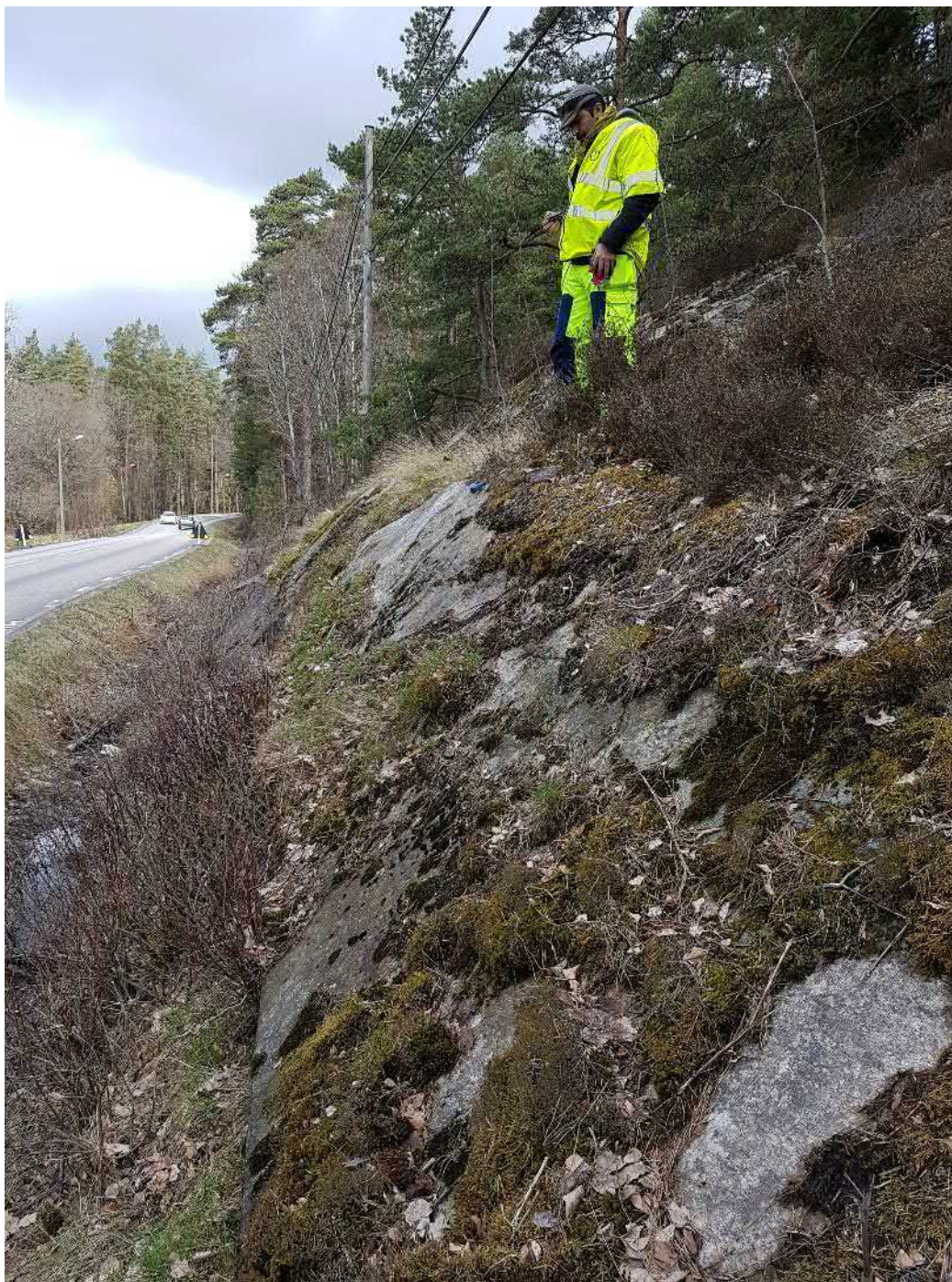
Figur 11 Foto på bergskärning 6.
