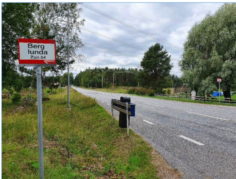
Figur 14. Busshållplats Berglunda där kollektivtrafikresenärer på väg till eller från busshållplatsen är hänvisade till den smala vägrenen längs väg 559.
