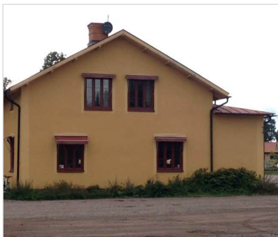
Figur 13. Bryggeribyggnadens södra fasad där fönster bytts på senare tid.
