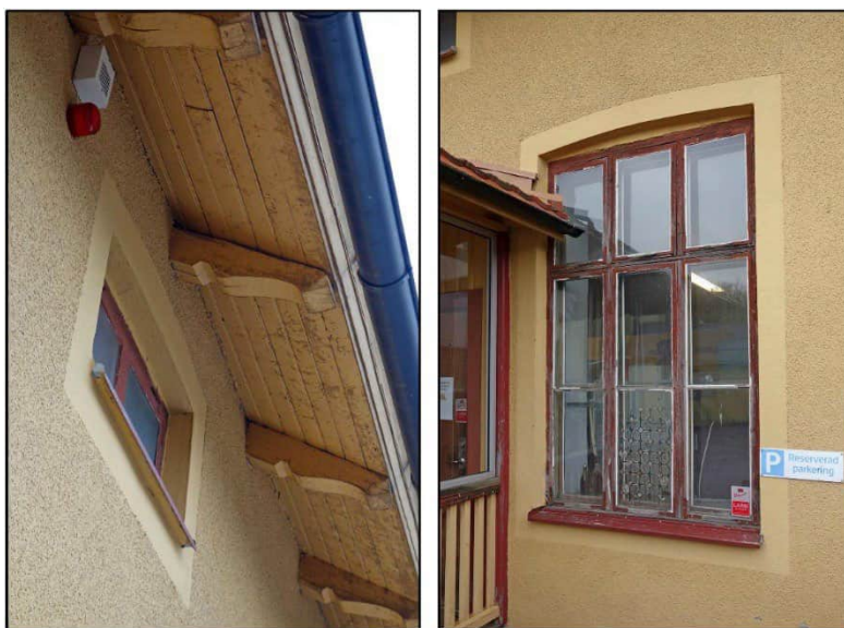
Figur 11 och 12. Bilder på byggnadsdetaljer som är relativt intakta på den befintliga bryggeribyggnaden. (Foto från antikvarisk utredning)
