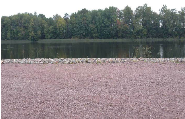
Figur 7. Bilden ovan visar erosionsskyddet vid strandkanten mot Storsjön.
