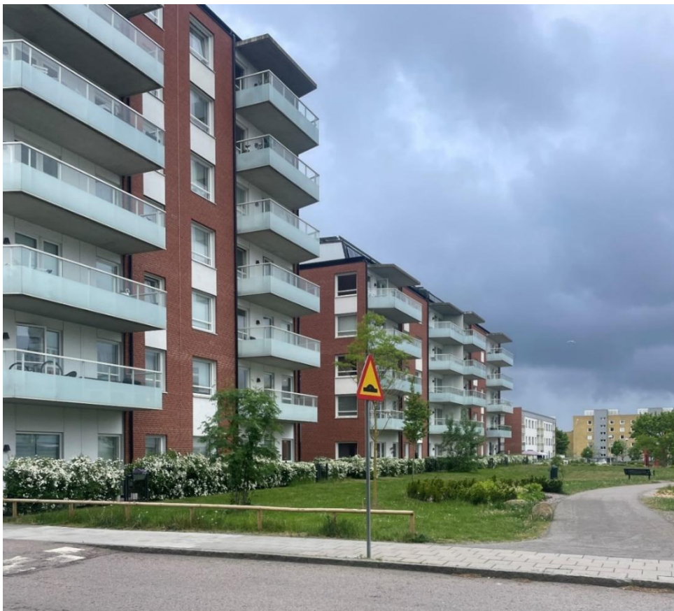
Figur 19. Flerbostadshus i Fredriksdal med öppen kvarterstruktur och en framträdande påtaglig grönska.
