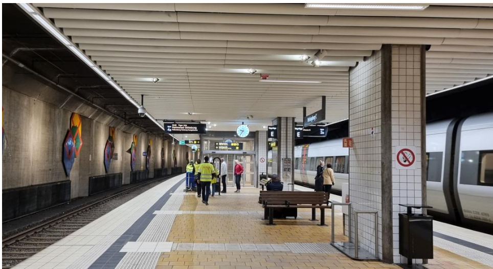
Figur 26. Foto över befintliga plattformar vid Helsingborg C.
