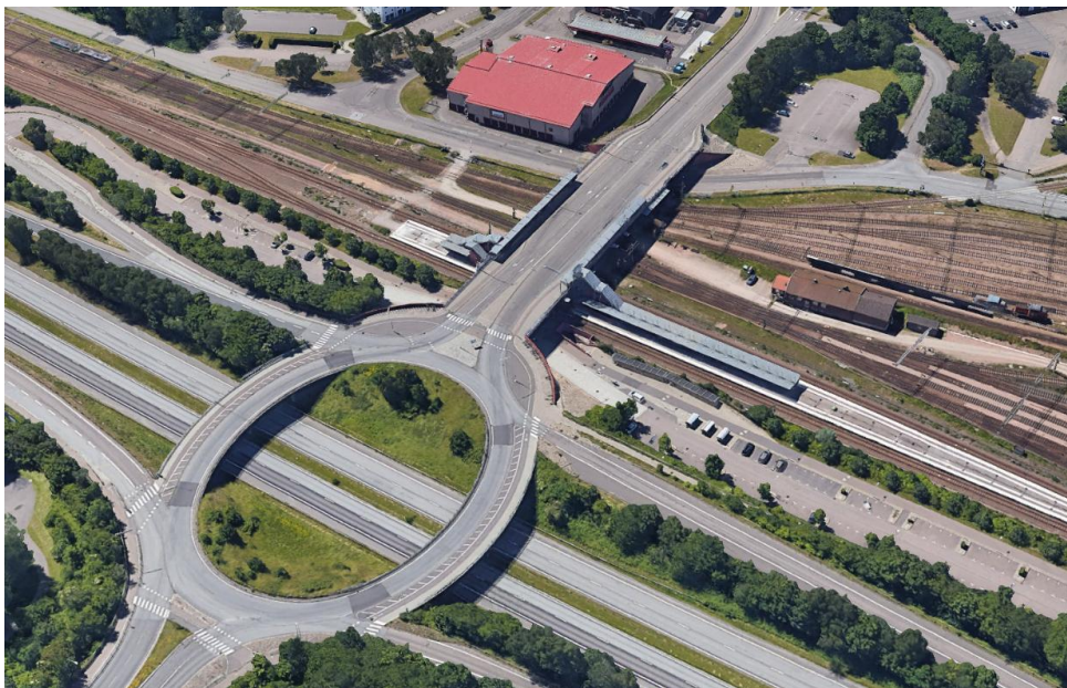
Figur 28. Flygbild över Ramlösa station.
