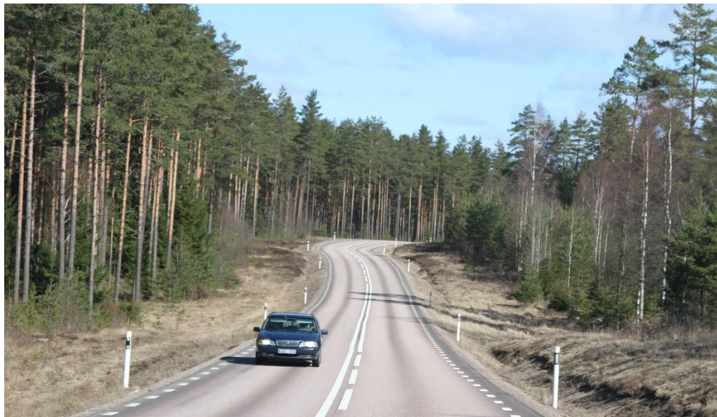
Bild 7 Väg 63 vy mot öster, sidoområdesåtgärder har genomförts i form av röjning bl.a.
