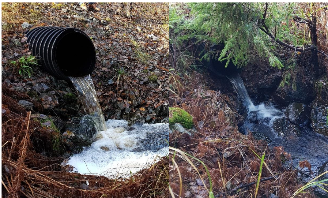
Figur 4.13 Trummor som kan antas utgöra vandringshinder för grod- och kräldjur. Bild till vänster: Trumma sydväst om Knipan/norr om Haget. Fotot taget på östra sidan av väg 2183 i västlig riktning. Bild till höger: Kvarnebäcken. Fotot taget på östra sidan av väg 2183 i västlig riktning.
