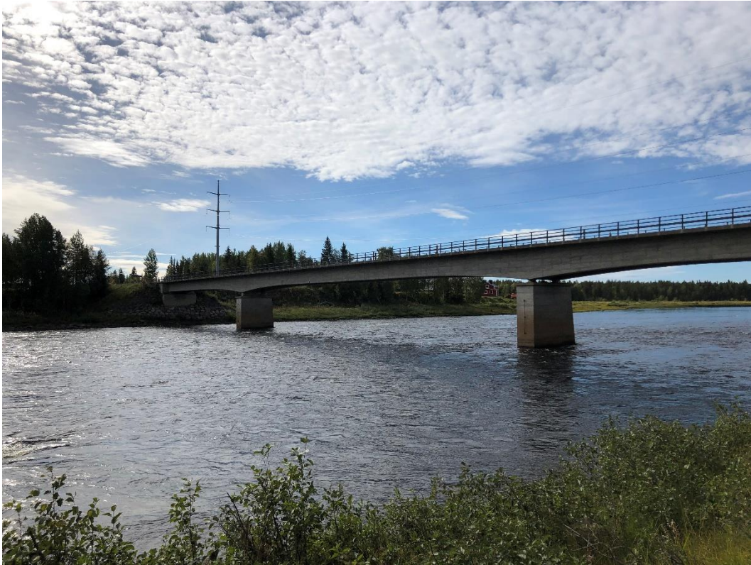
Figur 24. Befintlig bro sett från öster.
