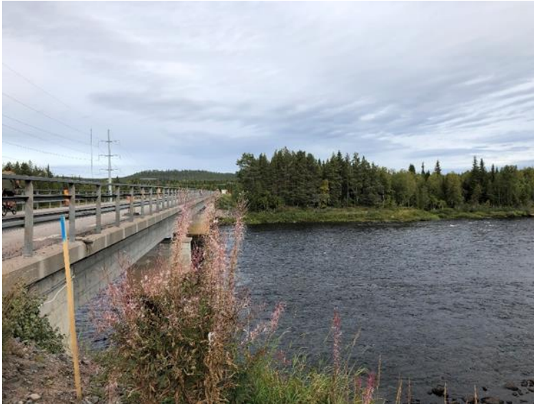
Figur 17 Östra sidan om befintlig bro sedd från södra sidan av Torneälven.
